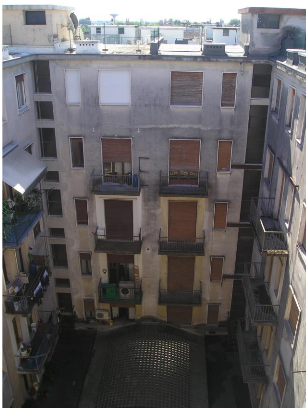
24. Vista dall'alto della copertura della galleria
