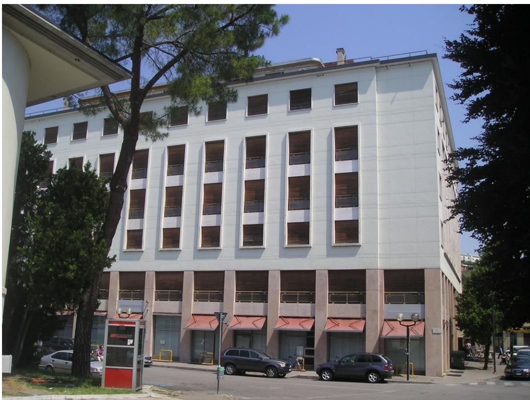
3. La parte dell'INAIL dell'edificio vista da via Roma: al piano terra i locali della banca, al primo quelli della vecchia Sede dell'INAIL, sopra gli appartamenti
