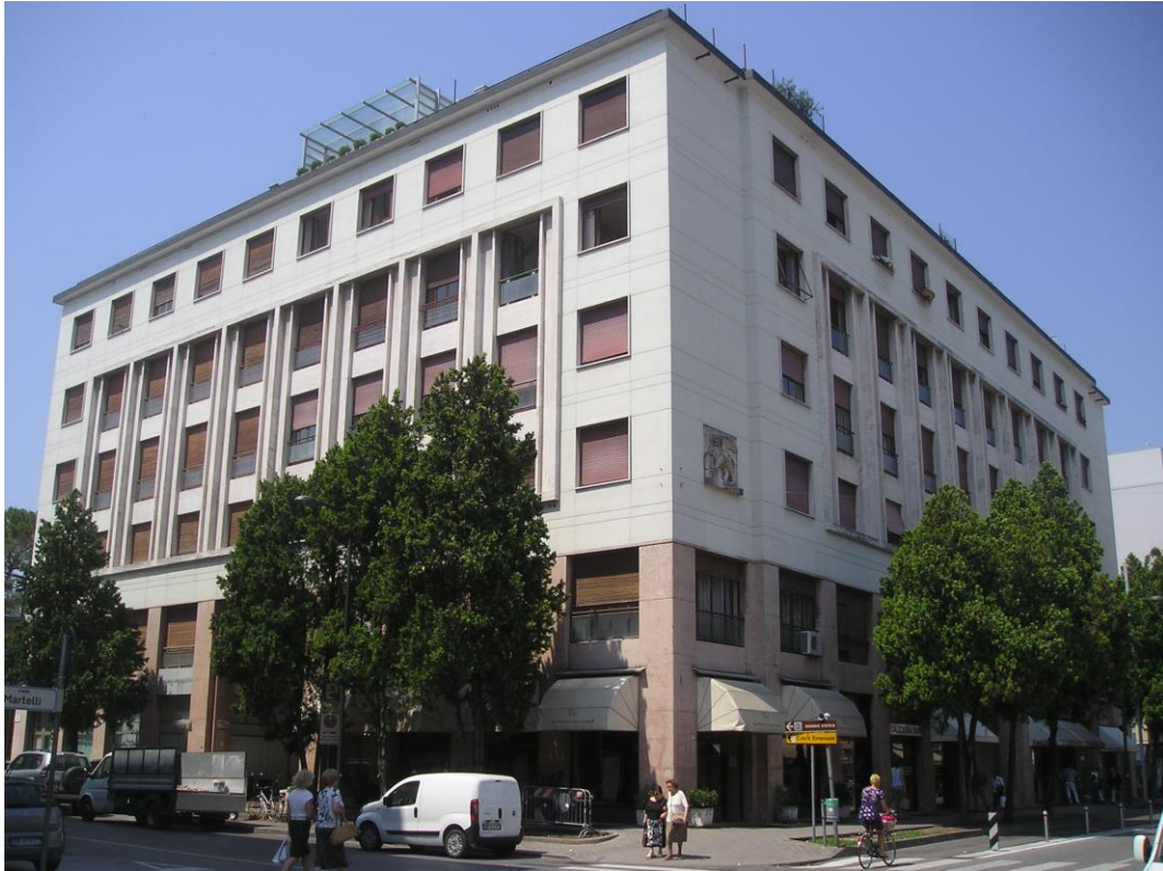
1. L'edificio visto da viale Martelli: a sinistra la parte dell'INAIL, a destra quella abitata
