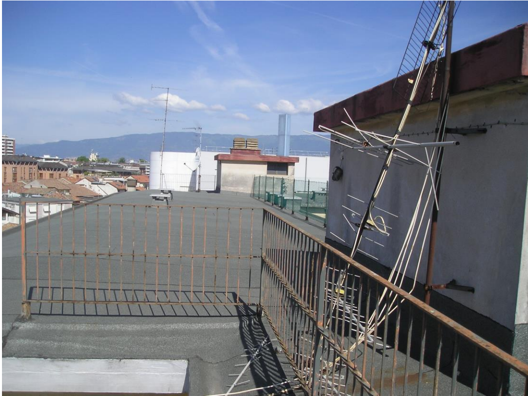
19. la copertura sopra il lato dell'INAIL
