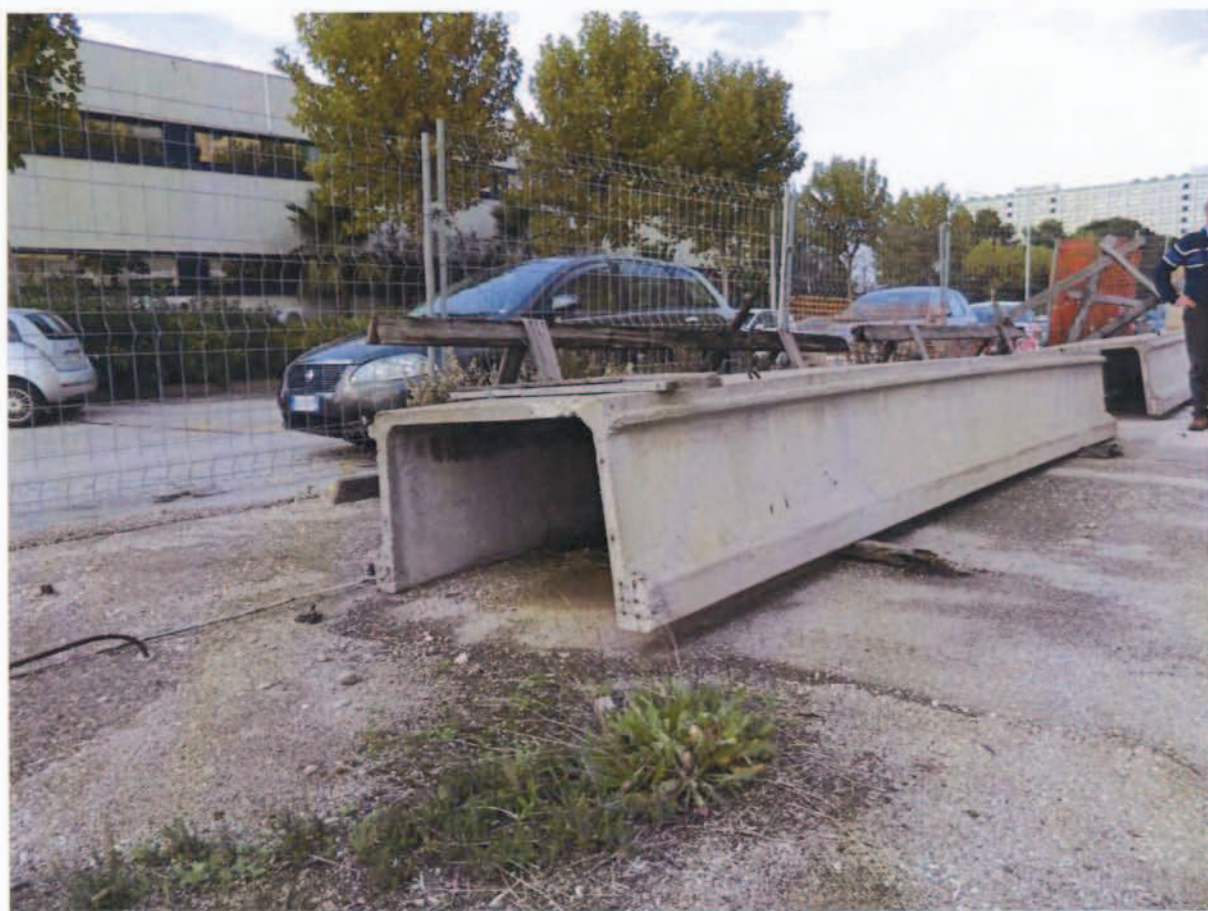
Tegolo costituente il solaio di calpestio dei piani
