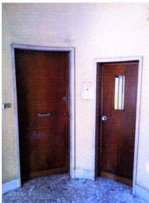
pianerottolo d'ingresso all'u.i. p. primo - int.1
