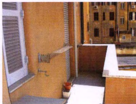
balcone cucina (facciata est)
