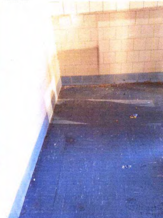
dettaglio pavimento cucina
