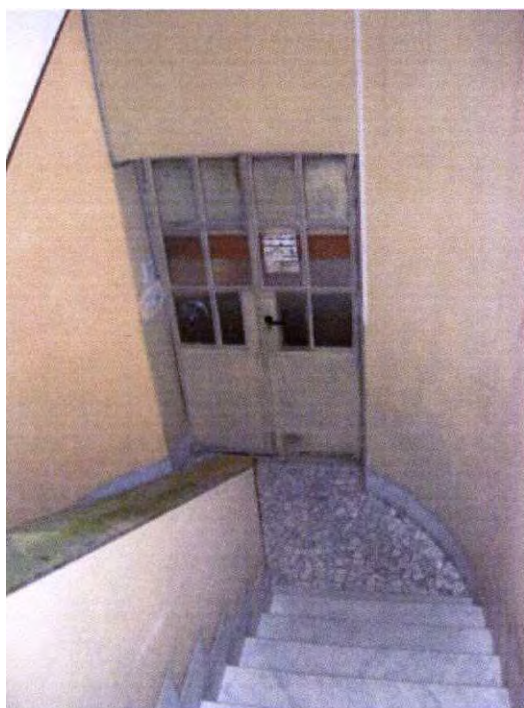
scala condominiale (accesso cantine)
