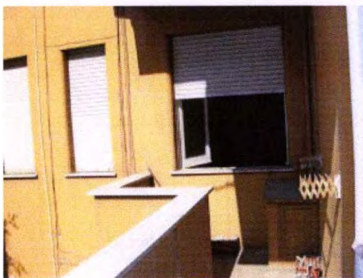
balcone cucina (facciata est)
