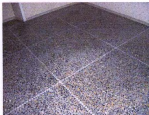
dettaglio pavimentazione camera da letto
