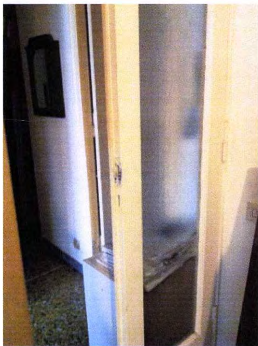
dettaglio infisso interno
