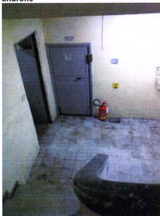
accesso al piano interrato
