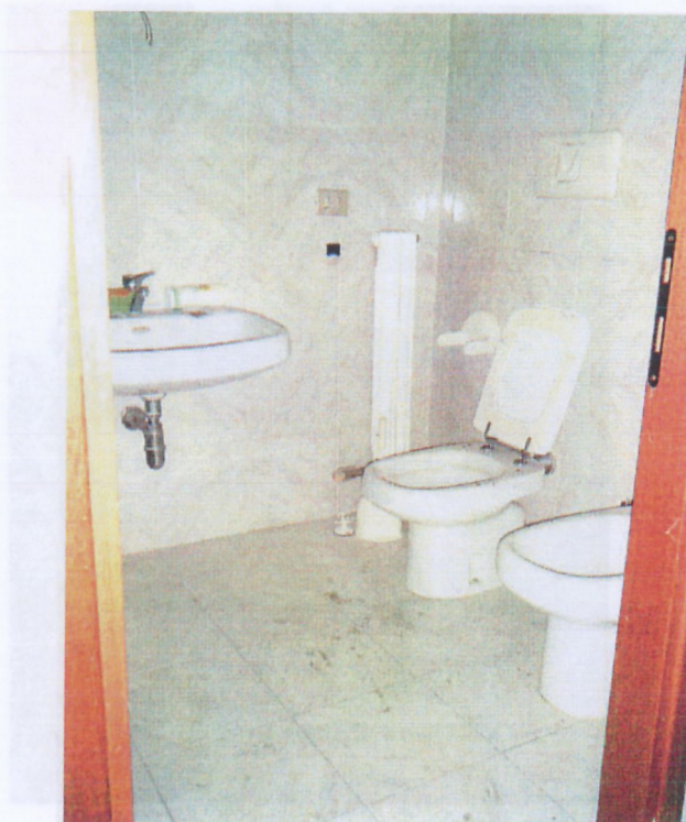
Bagno di servizio
