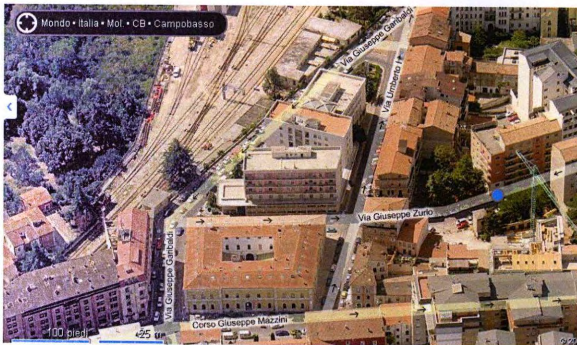
Figura 1- Vista aerea del blocco INAIL
