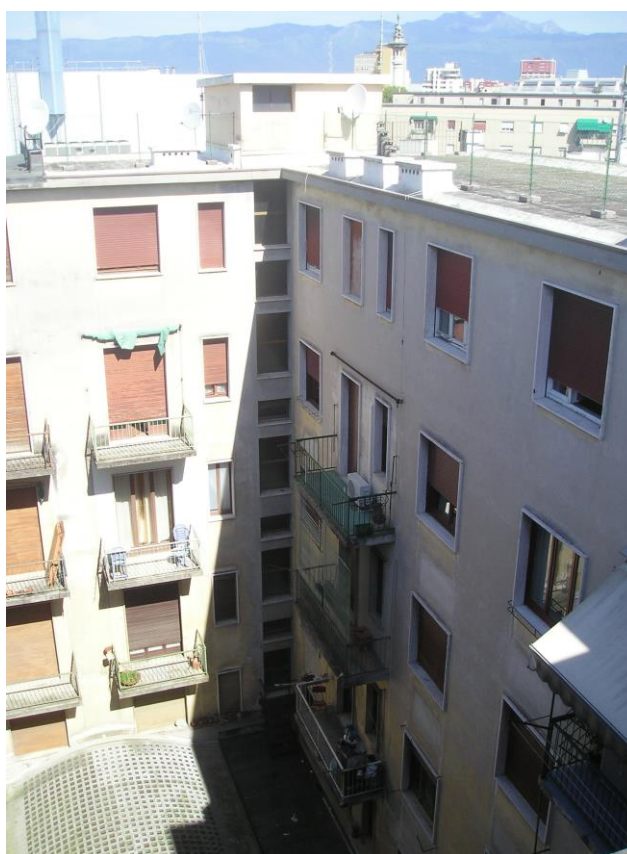
26. Le facciate interne alla corte centrale
