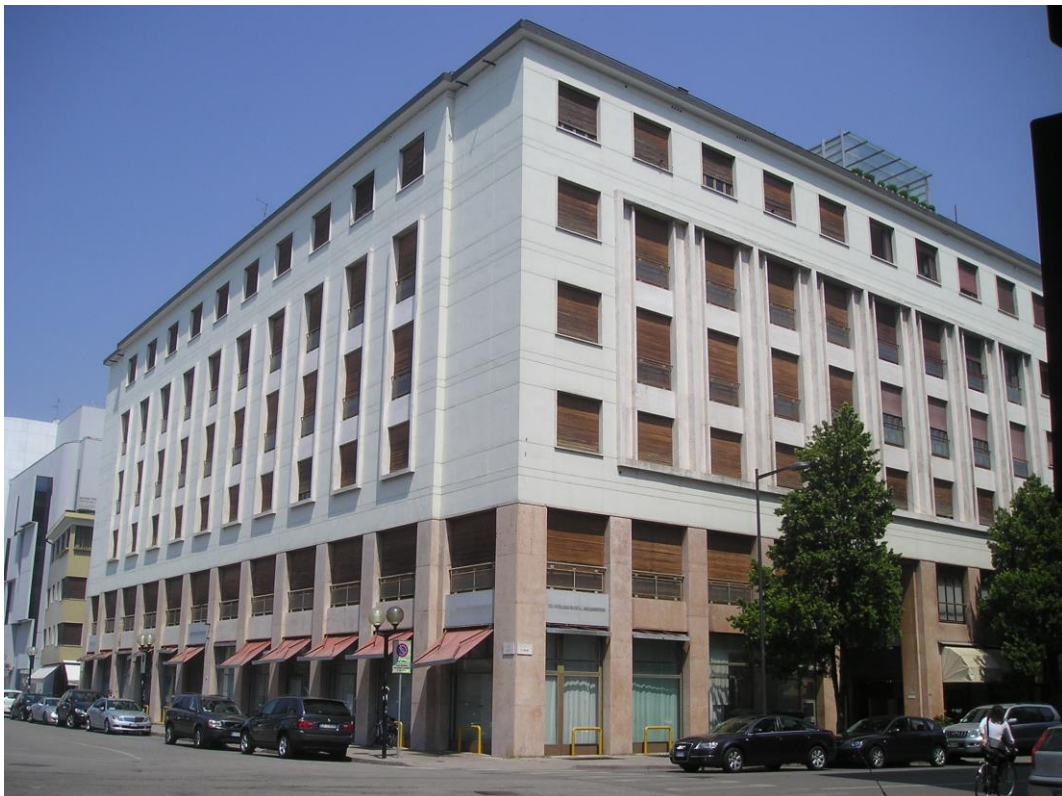
2. L'edificio visto da via Roma: al piano terra i locali della banca, al primo quelli della vecchia Sede dell'INAIL, sopra gli appartamenti e a destra la parte abitata
