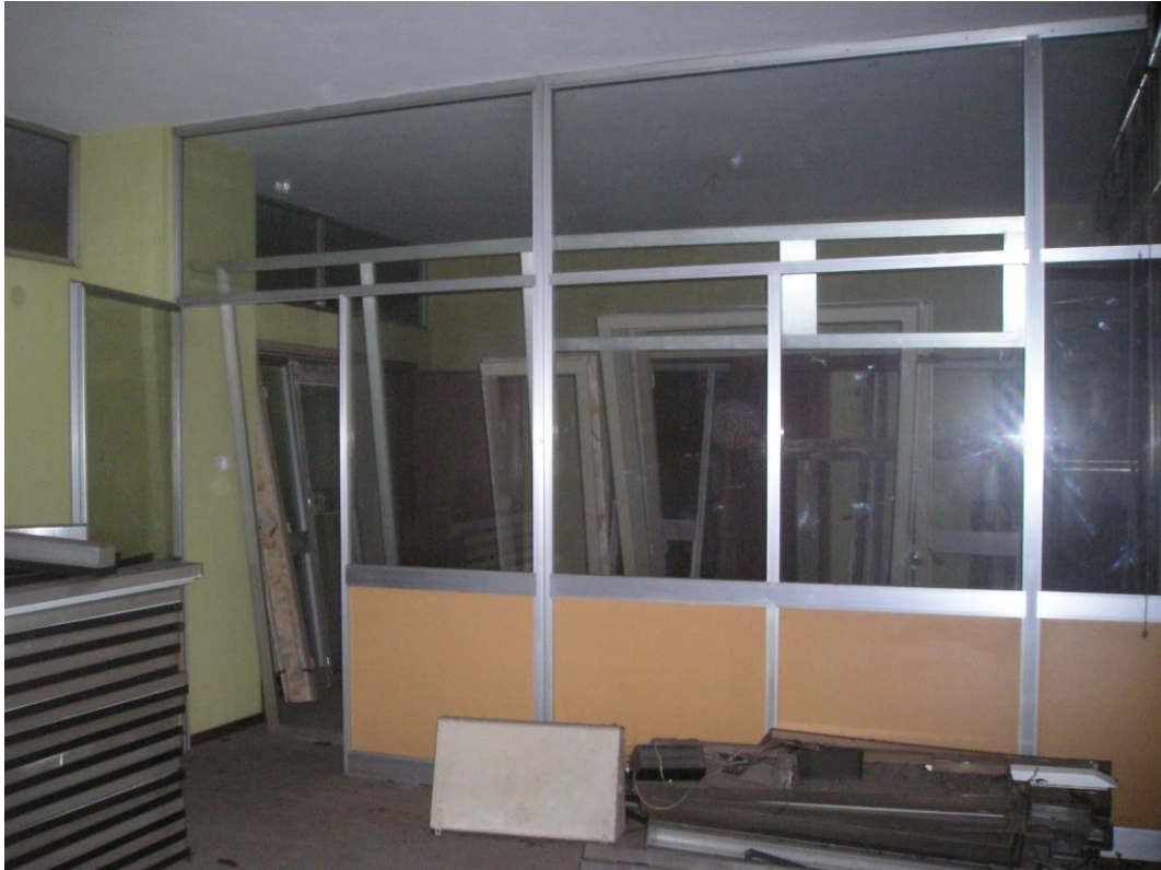
7. Serramenti e altri oggetti ammassati negli uffici della vecchia Sede INAIL al primo piano
