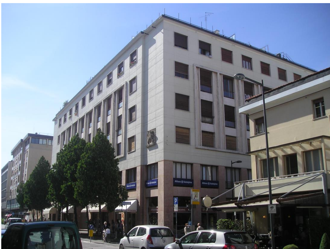
4. La parte abitata dell'edificio vista da viale Martelli
