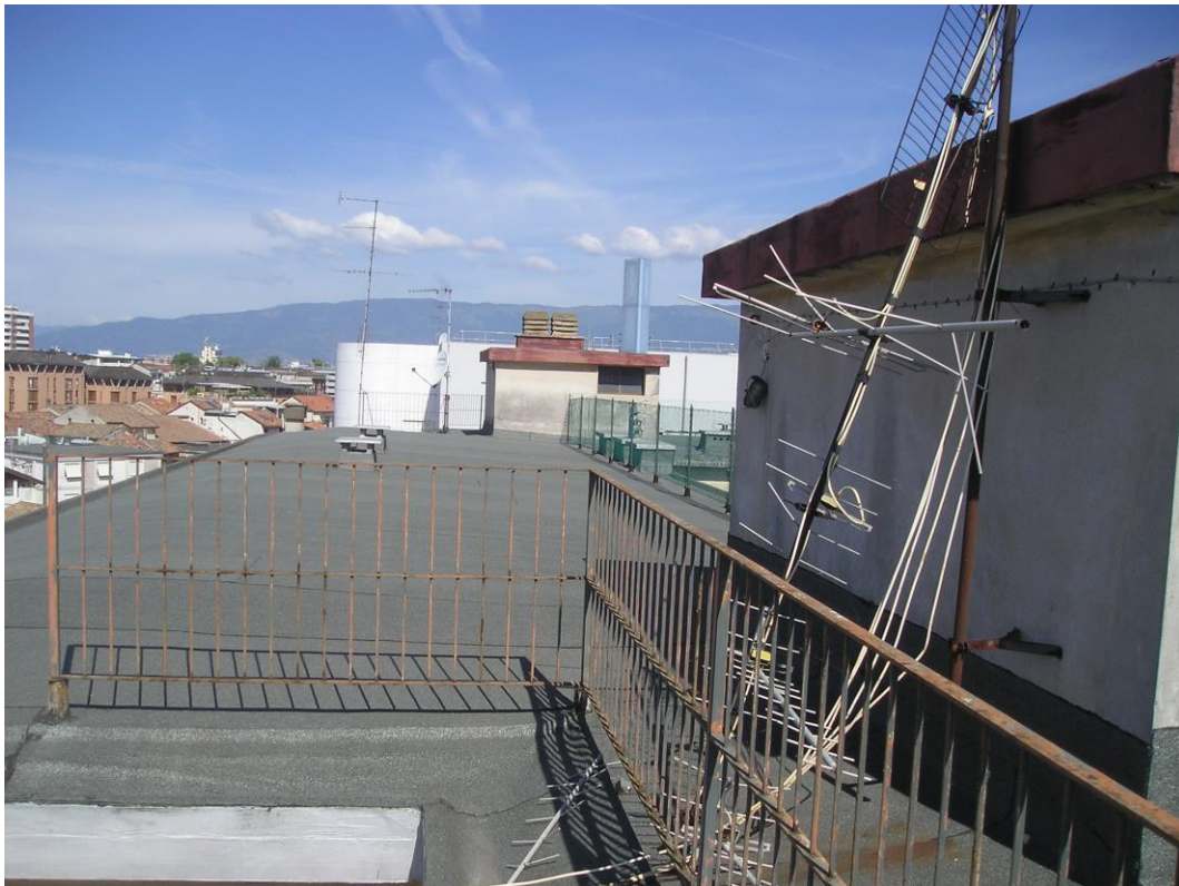
19. la copertura sopra il lato dell'INAIL
