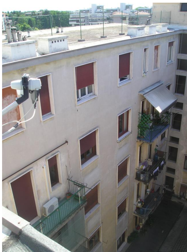
25 . Le facciate interne alla corte centrale
