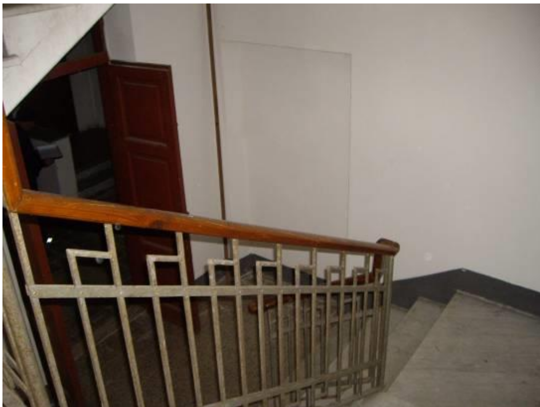
Vano scala accesso dall'androne
