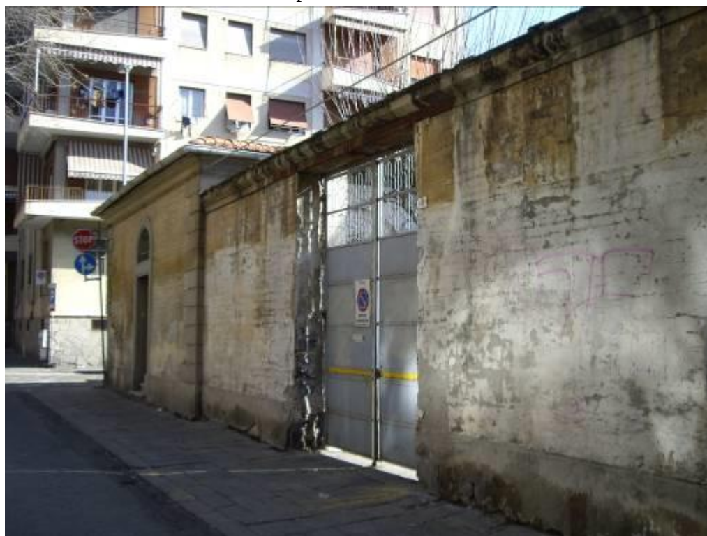
Accesso carraio su via Garibaldi
