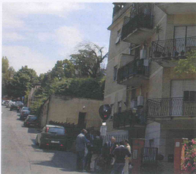
Fig.6 – Locale cantine. Particolare fotografico del manufatto nelle immediate adiacenze della palazzina alloggi.
