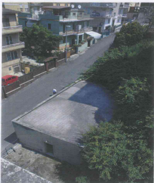
Fig.5 – Locale cantine. Particolare fotografico della copertura piana.
