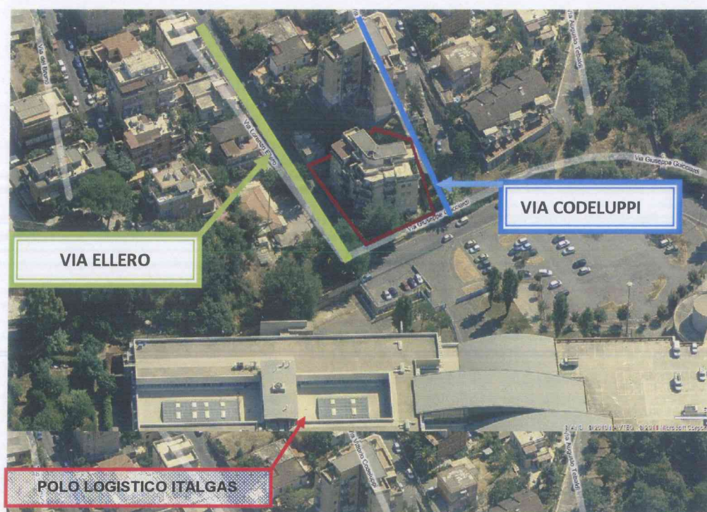
Fig.3 - Particolare fotografico della zona da cui si evince la posizione depressa del fabbricato rispetto agli altri ubicati su via Codeluppi e via Ellero.
