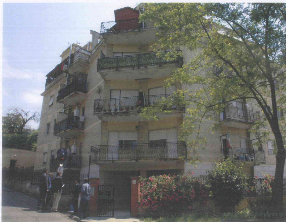
Fig.4 - Particolare fotografico dal quale si evince l'aspetto e le caratteristiche architettoniche del fabbricato. Vista lato nord ovest.
