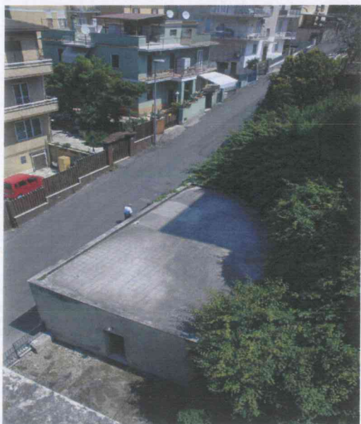
Fig.5 – Locale cantine. Particolare fotografico della copertura piana.
