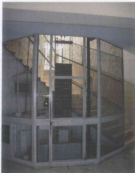
Fig.9 – Impianto ascensore. Particolare fotografico dell'accesso all'impianto dal piano terra.
