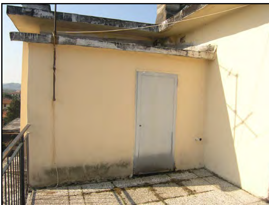
Foto 25 – Accesso ex vaso espansione aperto
