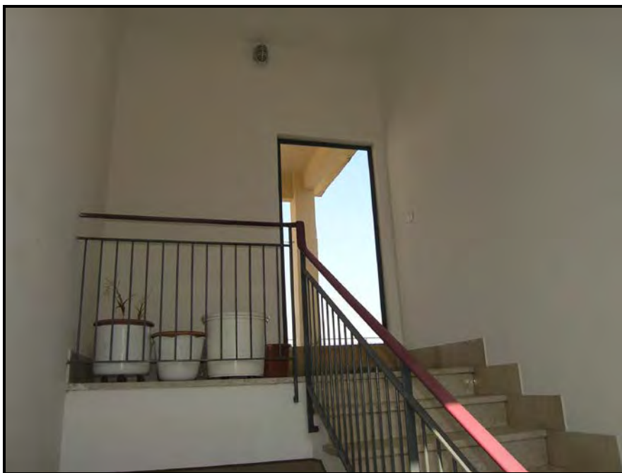
Foto 22 – Accesso lastrico solare comune
