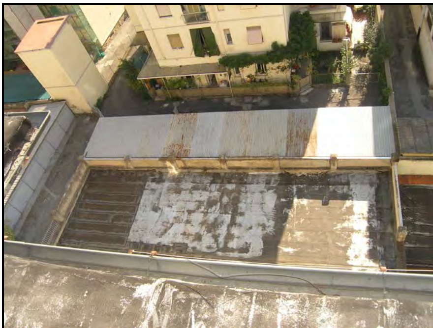
Foto 29 – Vista copertura garage
