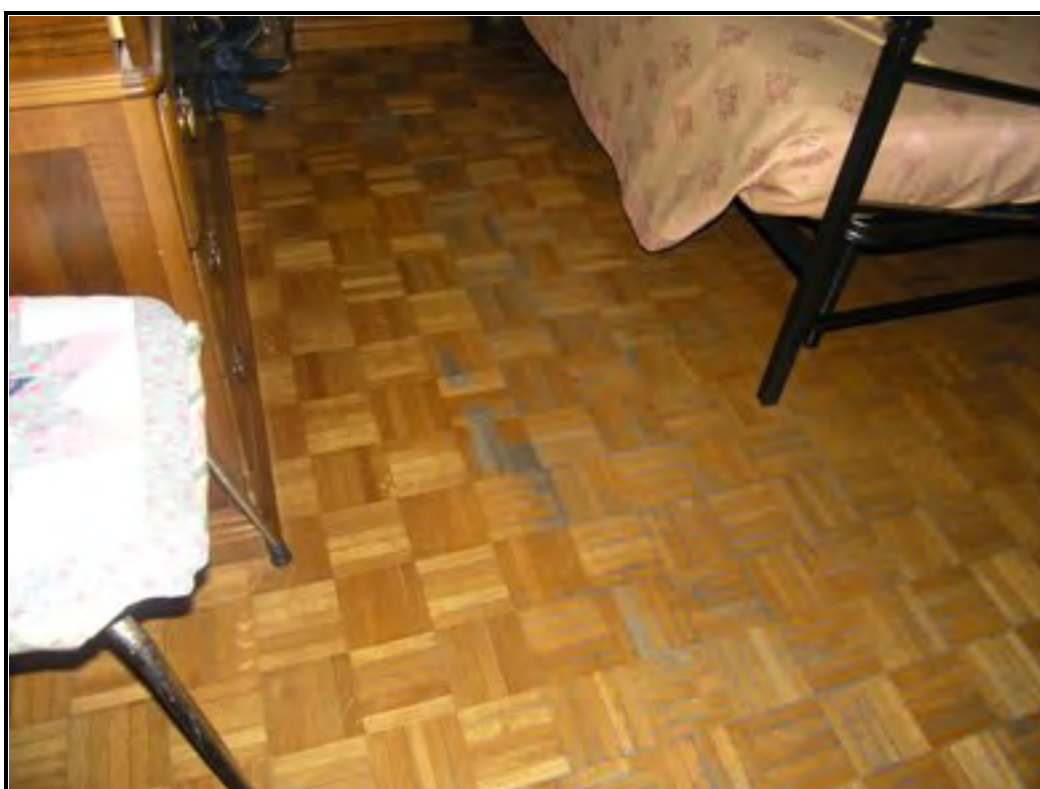
Foto 10 – Seconda camera da letto - Particolare pavimento in parquet
