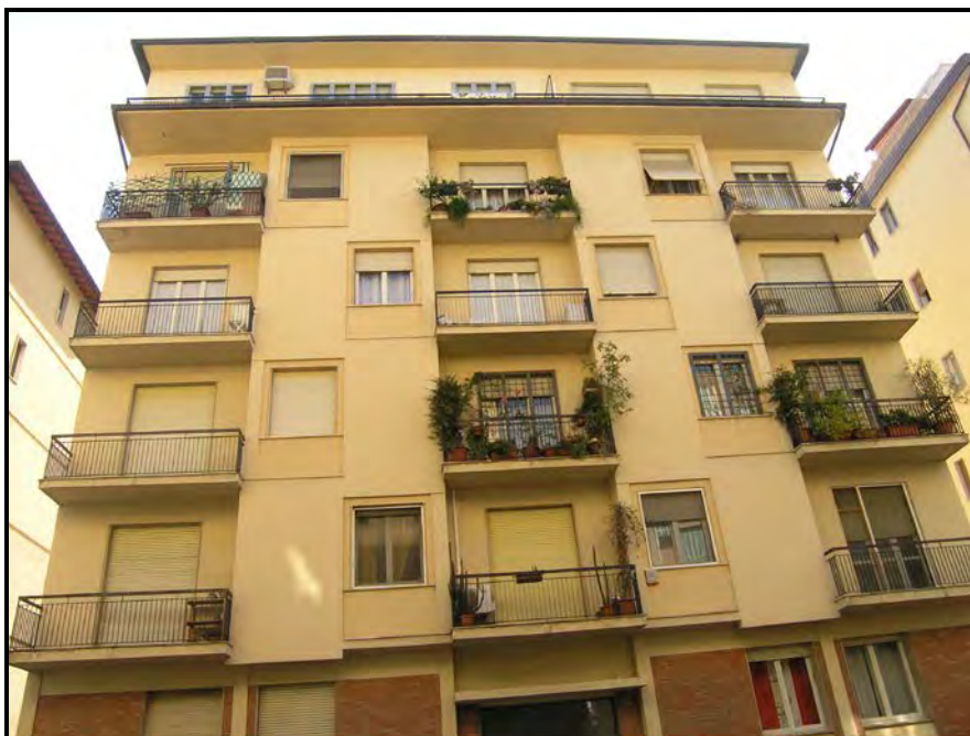
Foto 3 – Facciata su via dell'Arcolaio 44A - 1
