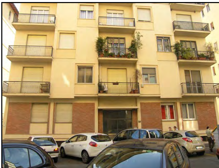
Foto 1 – Facciata su via dell'Arcolaio 44A
