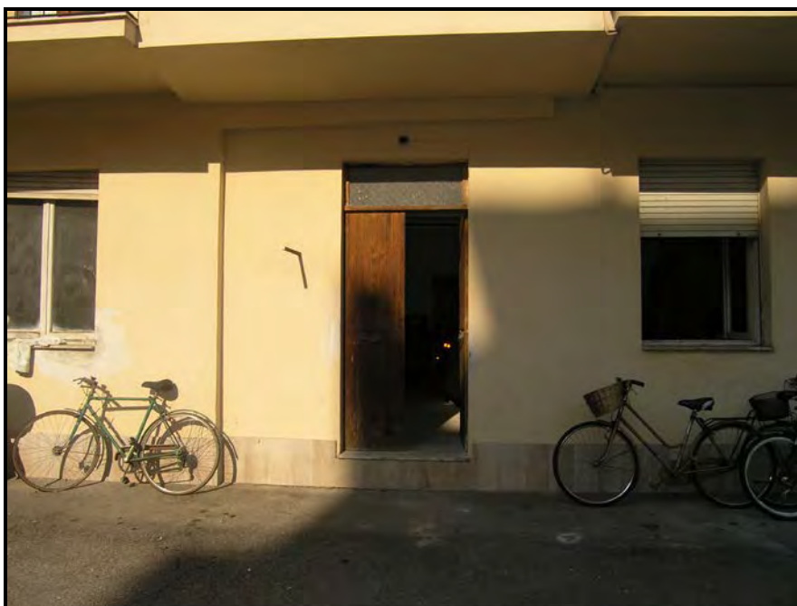
Foto 11 – Accesso cantina comune
