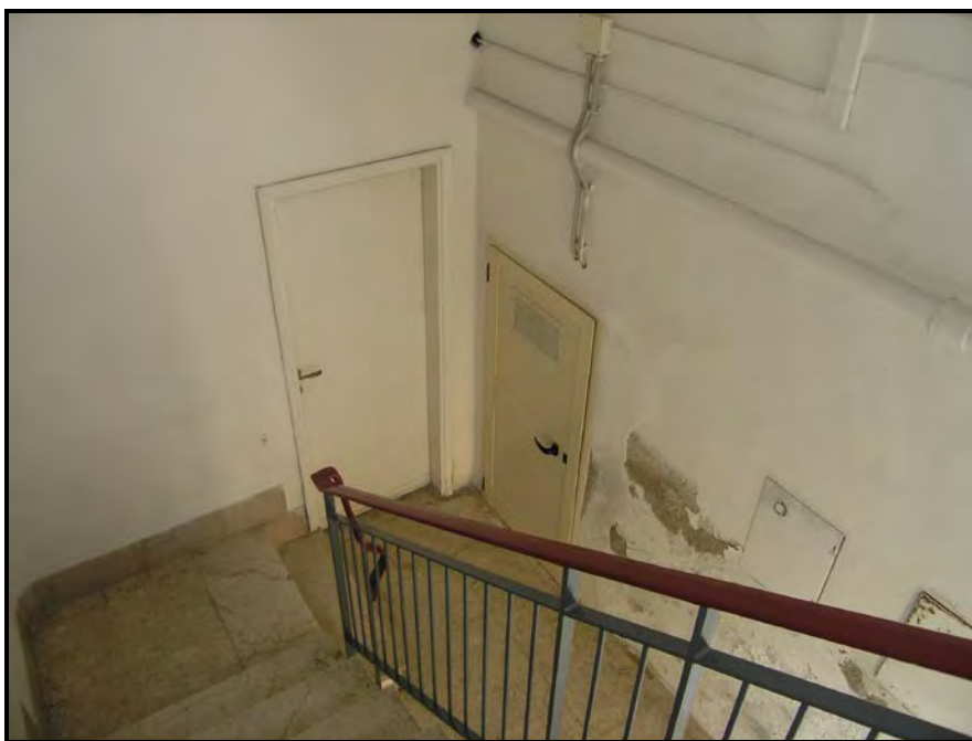
Foto 10 – Rampa scale discendente su cantina comune
