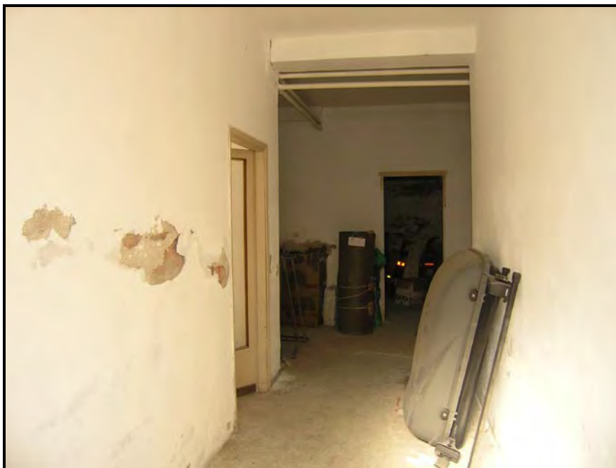
Foto 13 - Locale deposito - Immagine 1
