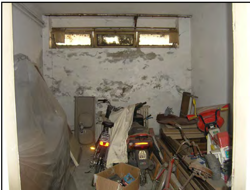
Foto 15 – Locale deposito - Immagine 3
