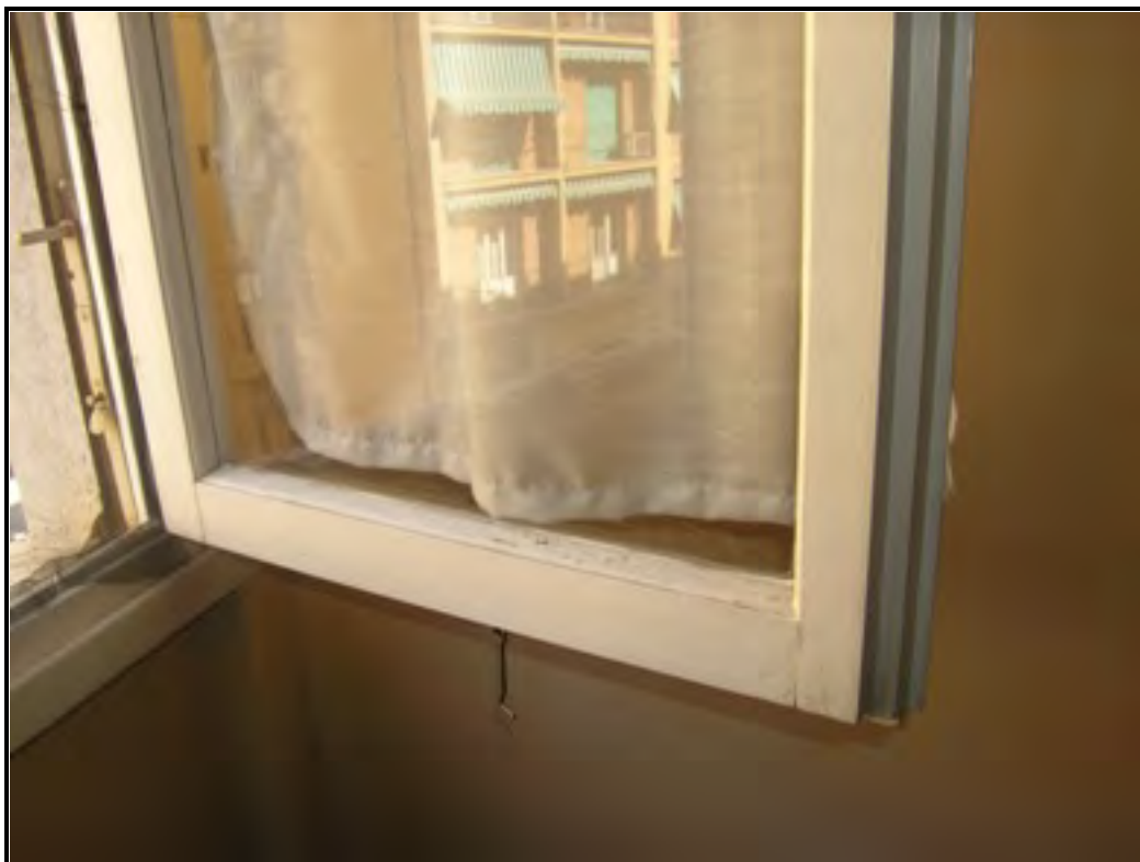
Foto 03 – Disimpegno - Particolare infissi
