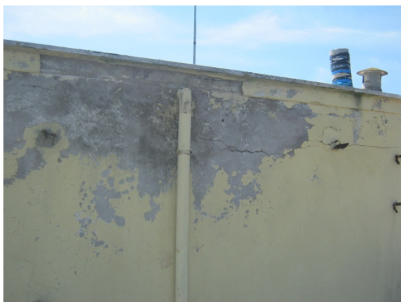
Fig. 21 – Particolare della facciata
