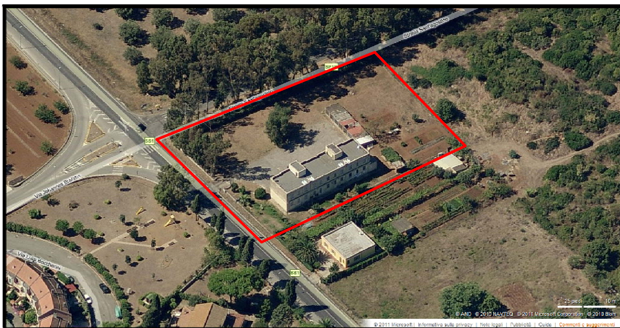
Fig. 4 – Vista dall'alto dell'edificio. Particolare fotografico relativo ai confini del sedime su cui sorge il fabbricato.
