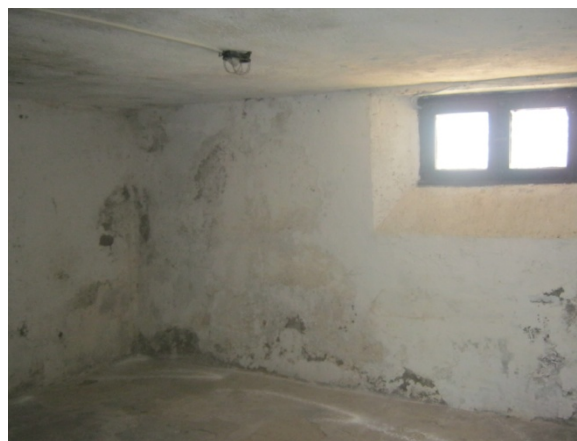
Fig. 22 – Particolare delle cantine.
