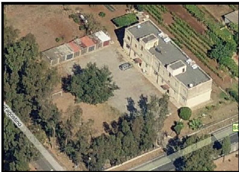
Fig. 5 – Vista del fabbricato dal lato SUD.
