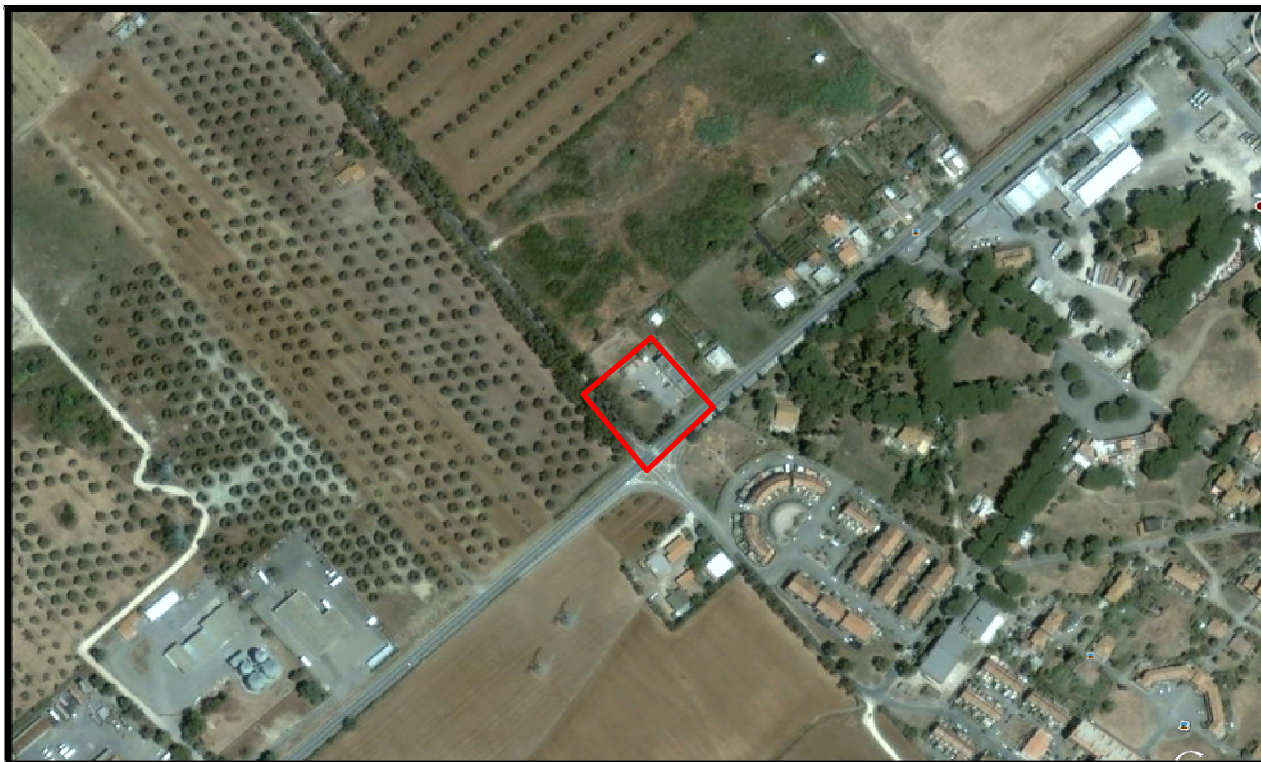
Fig. 3 – Ortofoto. Particolare fotografico relativo ai confini del sedime su cui sorge il fabbricato.
