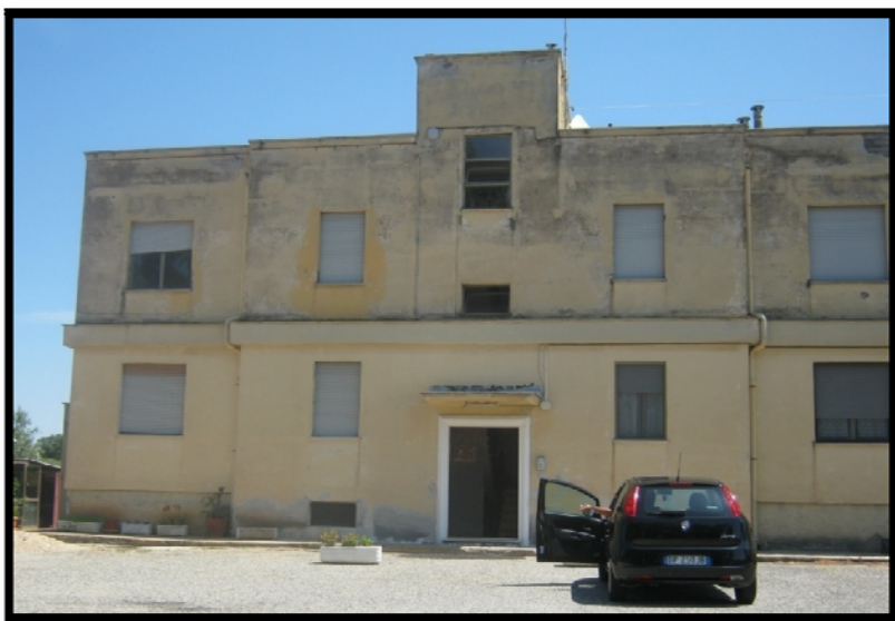
Fig. 10 – Prospetto principale lato sinistro.
