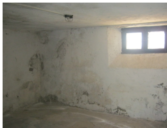
Fig. 22 – Particolare delle cantine.
