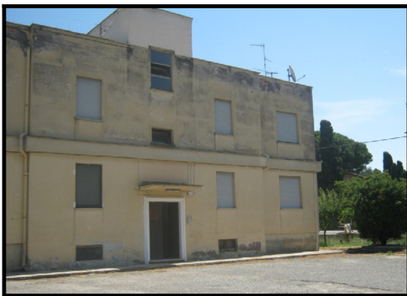
Fig. 11 – Prospetto principale lato destro.
