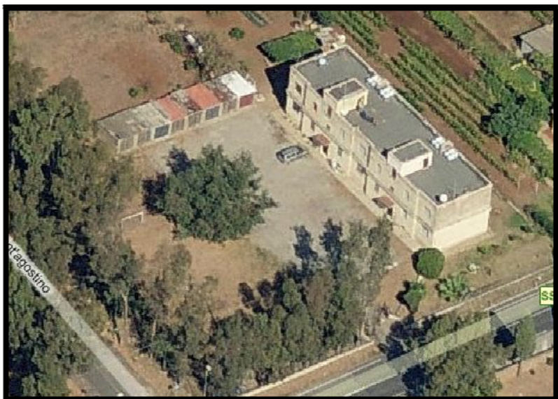
Fig. 5 – Vista del fabbricato dal lato SUD.
