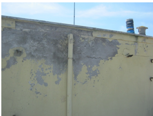
Fig. 21 – Particolare della facciata
