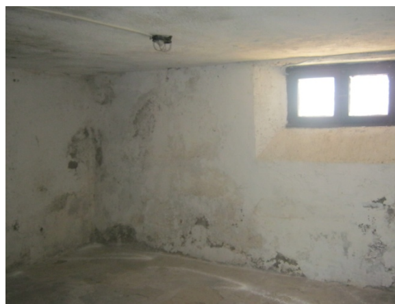
Fig. 22 – Particolare delle cantine.
