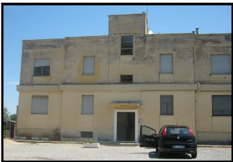
Fig. 10 – Prospetto principale lato sinistro.
