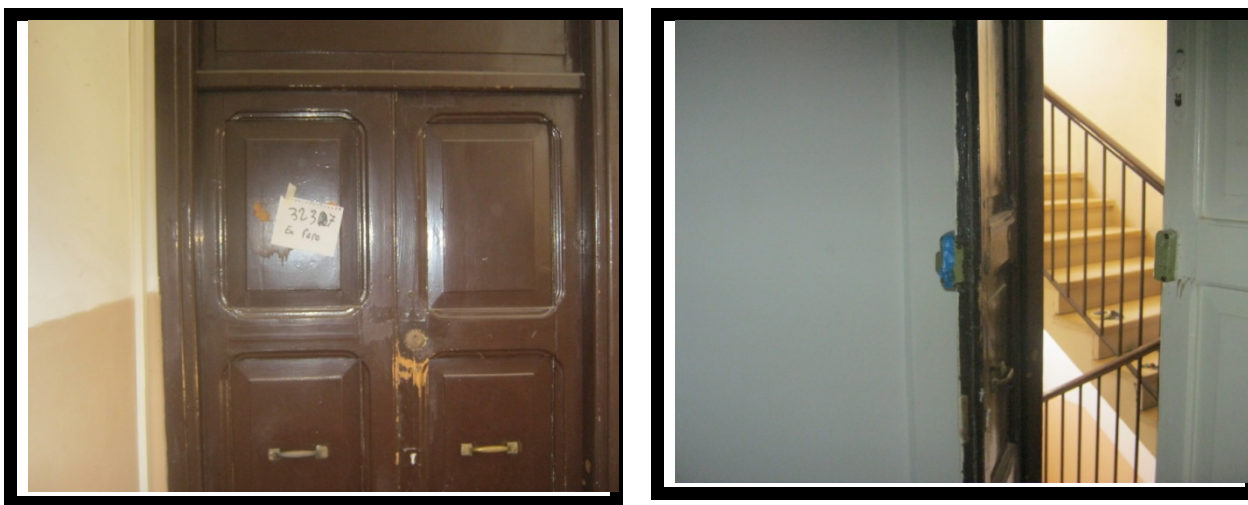
Fig. 12 – Porta di ingresso della abitazione.
