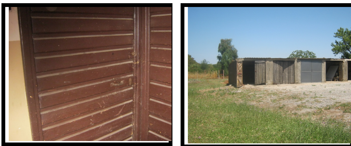
Fig. 15 – Porta di ingresso della cantina e del deposito.
