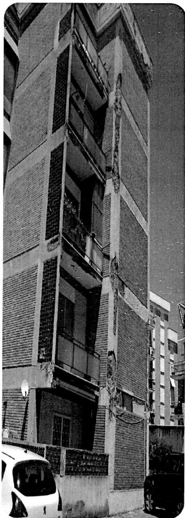
Foto 7 - Vista lato sud-est del fabbricato A
