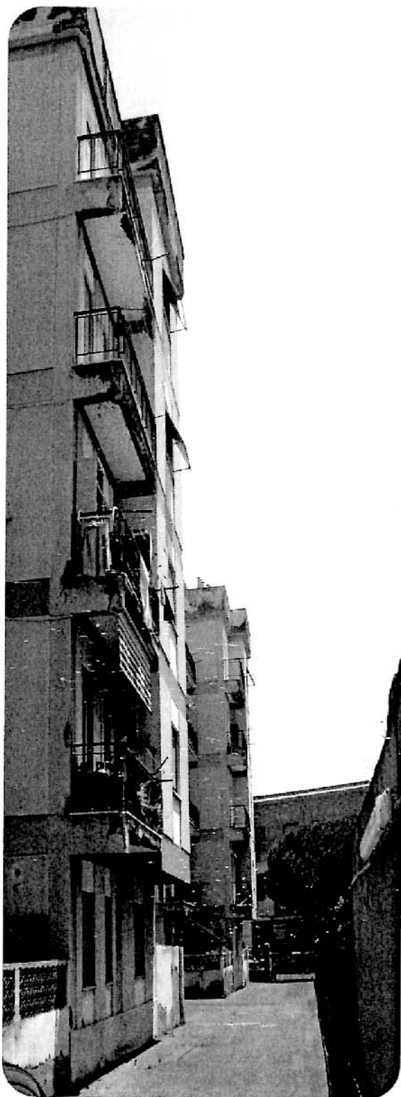
Foto 15 - Vista lato nord-ovest fabbricati A e B
