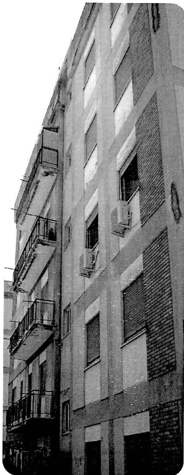
Foto 16 - Vista lato nord del fabbricato B
