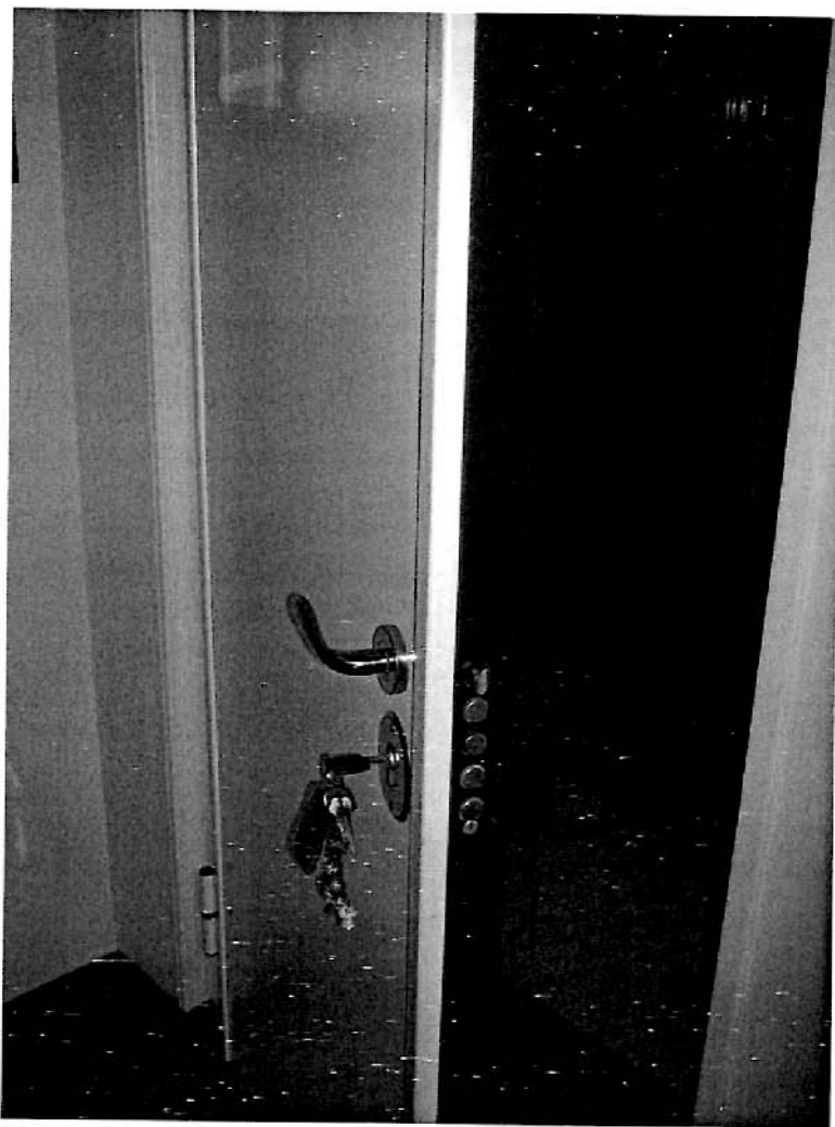
Foto A8 – Particolare della porta d'ingresso
