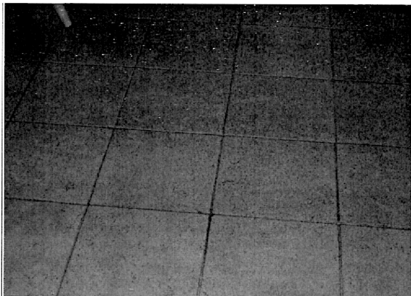
Foto A1 - Particolari della pavimentazione dell'alloggio
