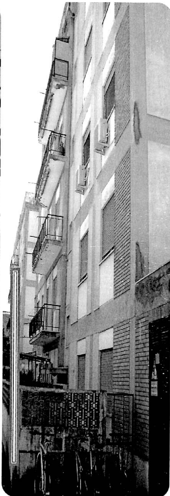
Foto 14 - Facciate principali fabbricati A e R
