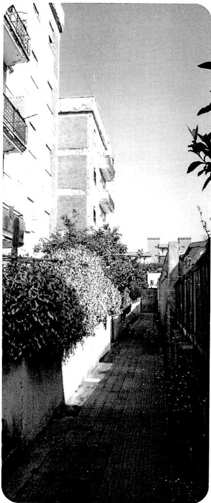
Foto 13 - Vista lato sud dei fabbricati A e R
