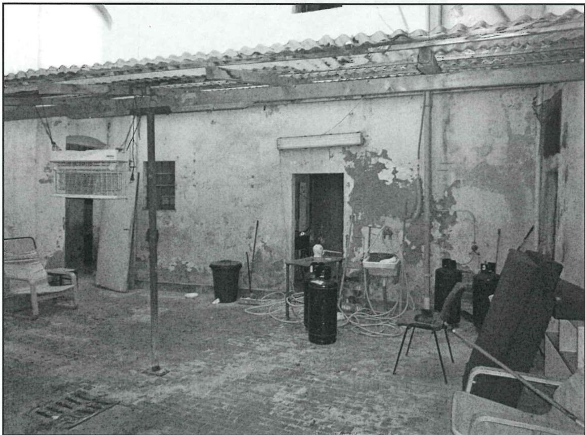
**Foto 8 – Corte interna comune. Intonaci e pavimenti ammalorati**
