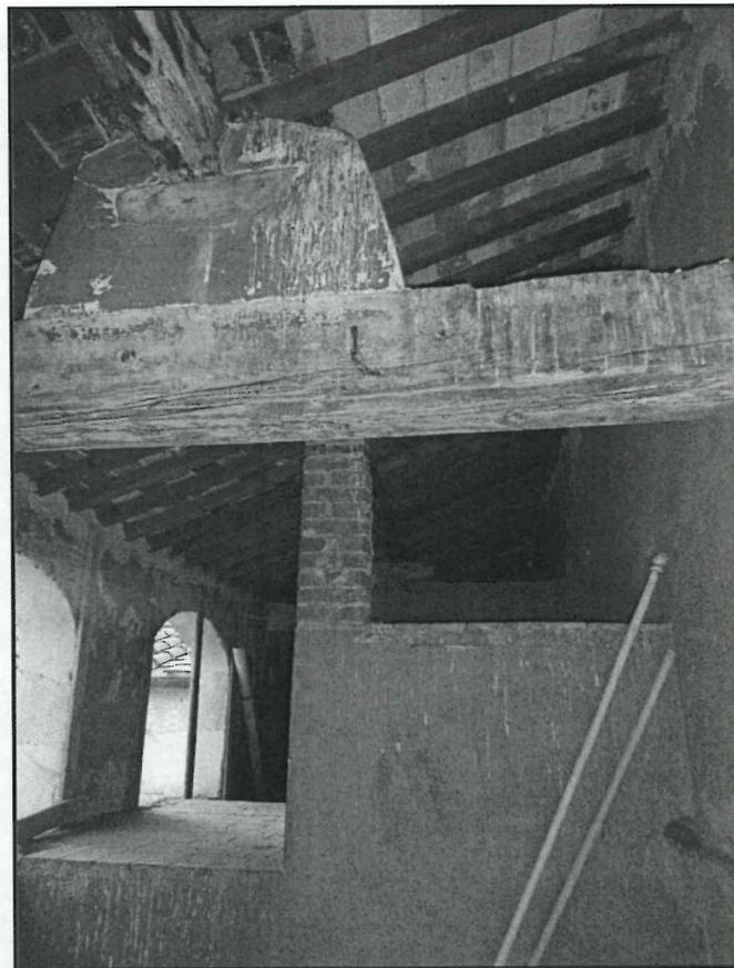
Foto 18 – Piano soffitte. Struttura lignea della copertura a tetto
