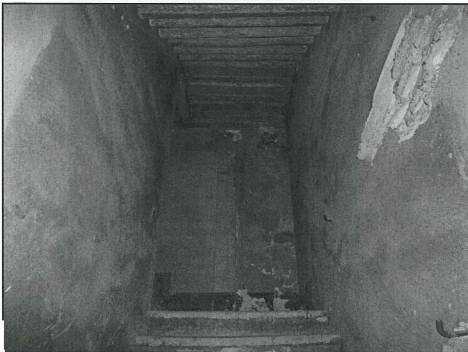
Foto 14 – Vano scala che conduce a soffitte (Civ.17) – P. Ammezzato. Intonaci fatiscenti
