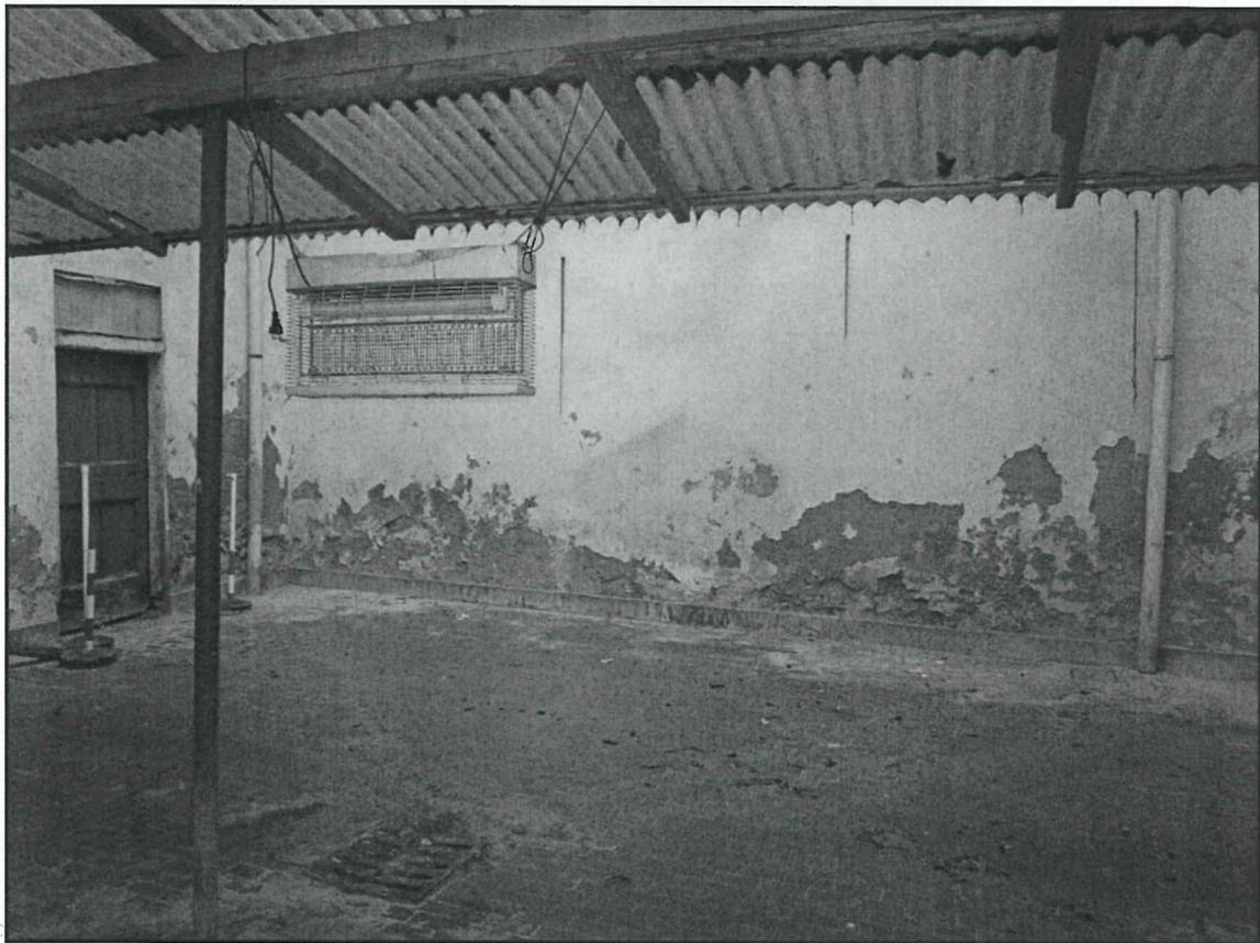
**Foto 6 – Corte interna comune. Intonaci e pavimenti ammalorati**
