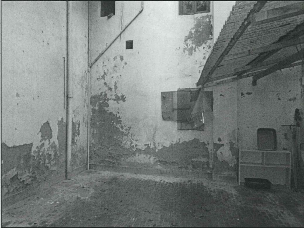
**Foto 9 – Corte interna comune. Intonaci e pavimenti ammalorati**
