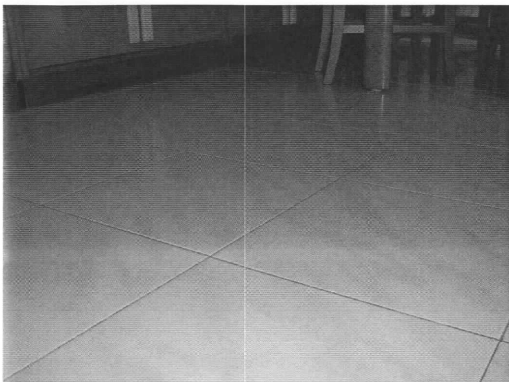
Foto n° 17 – Particolare pavimenti alloggio
