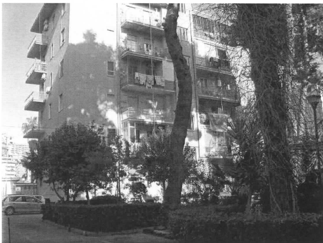
Foto n° 5 – Vista dell'immobile dal lato posteriore
