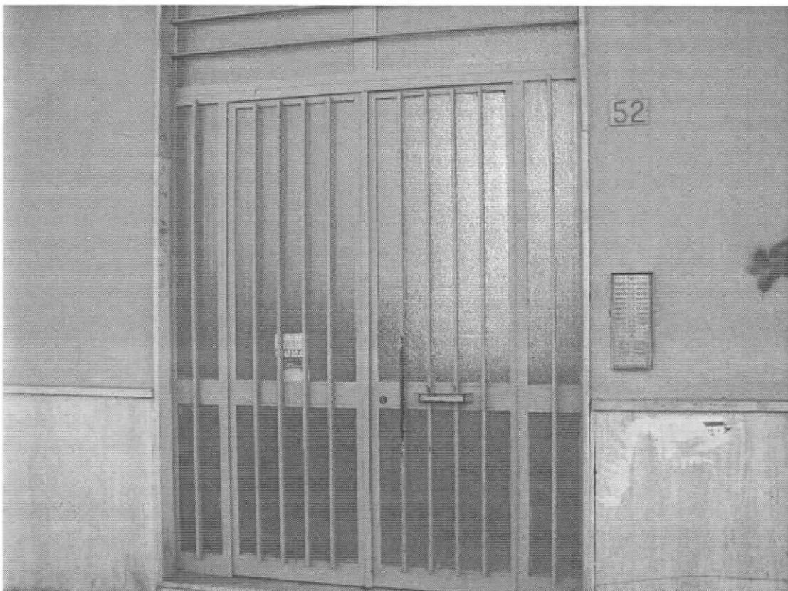
Foto n° 3 – Vista dell'immobile dal cancello pedonale
