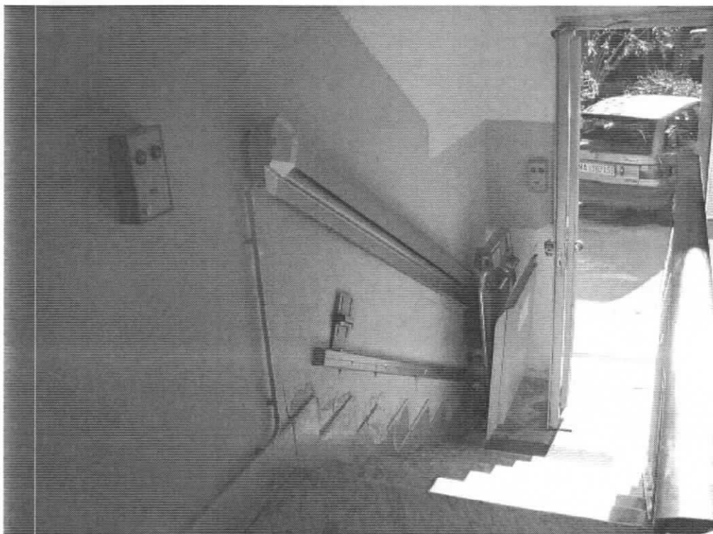
Foto n° 9 – Particolare montacarichi accesso secondario pedonale
