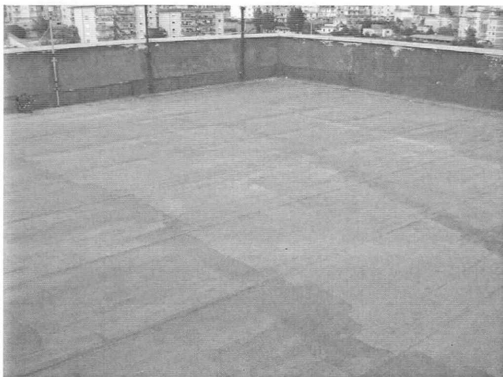
Foto n° 11 – Particolare manto di copertura terrazzo
