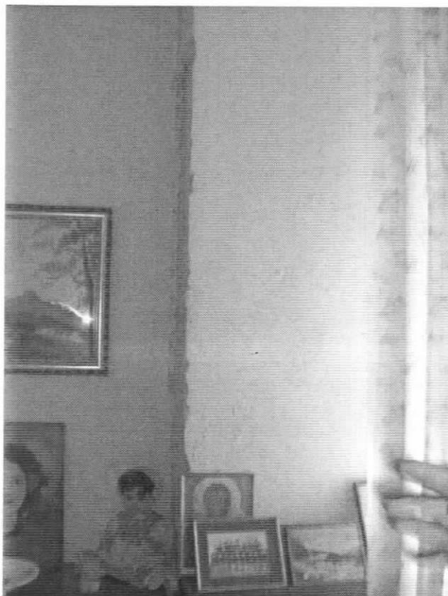
**Foto n° 13 – Particolare infiltrazioni interno alloggio**
