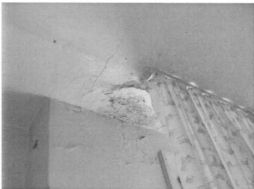
**Foto n° 18 – Particolare infiltrazioni interno alloggio**
