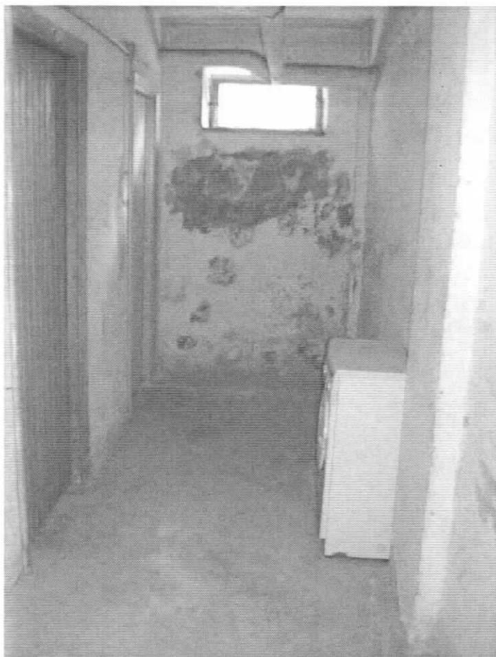
**Foto n° 10 – Particolare umidità e infiltrazioni cantinole**
