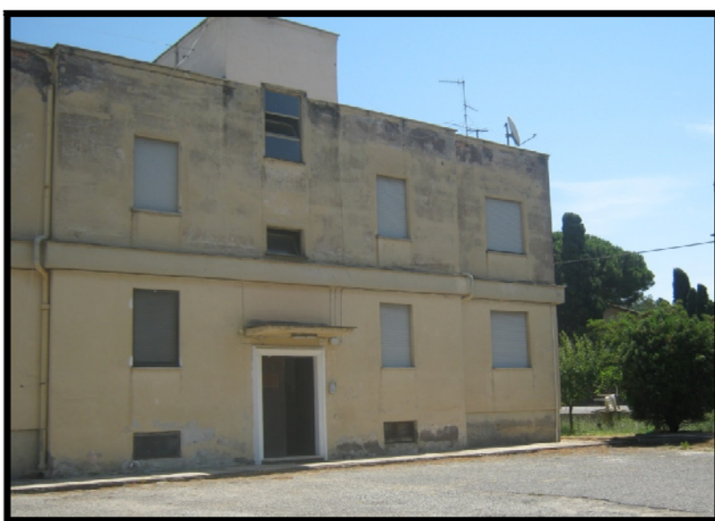
Fig. 11 – Prospetto principale lato destro.
