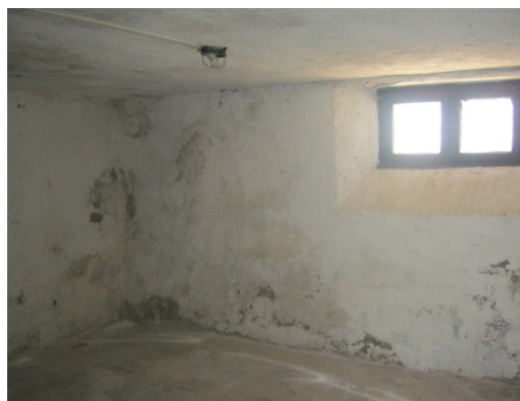
Fig. 22 – Particolare delle cantine.
