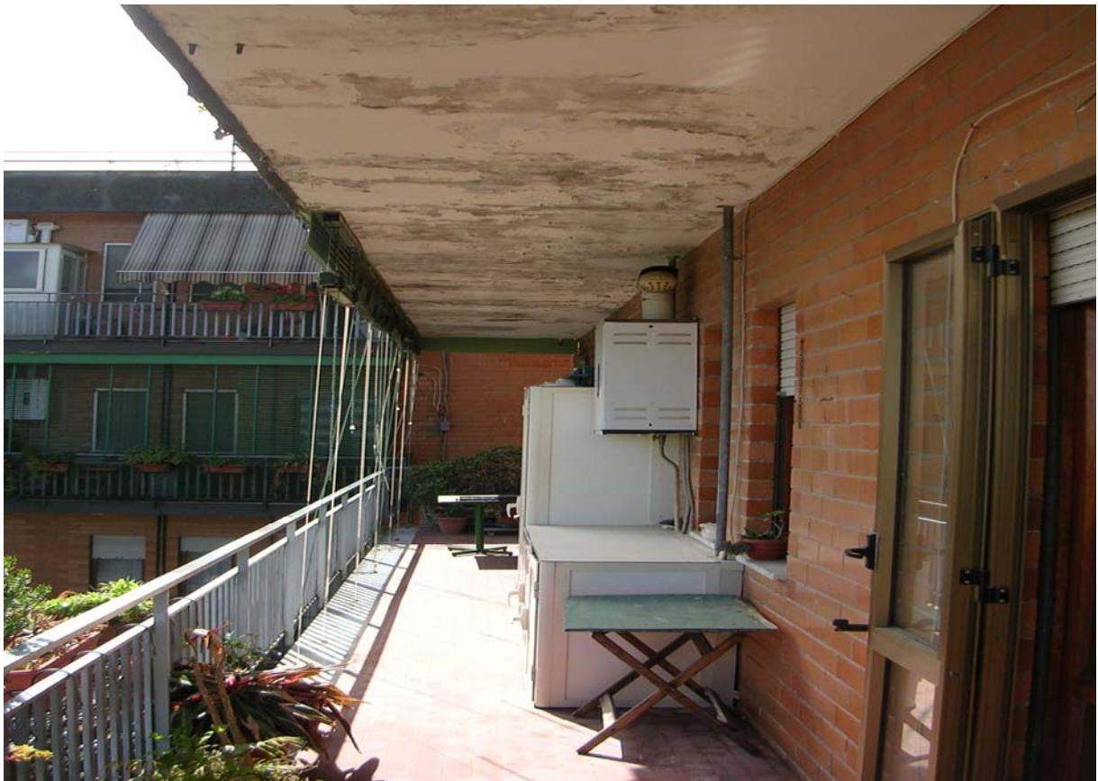
**Foto n° 6 – Particolare stato intradossi – frontalini balconi**
