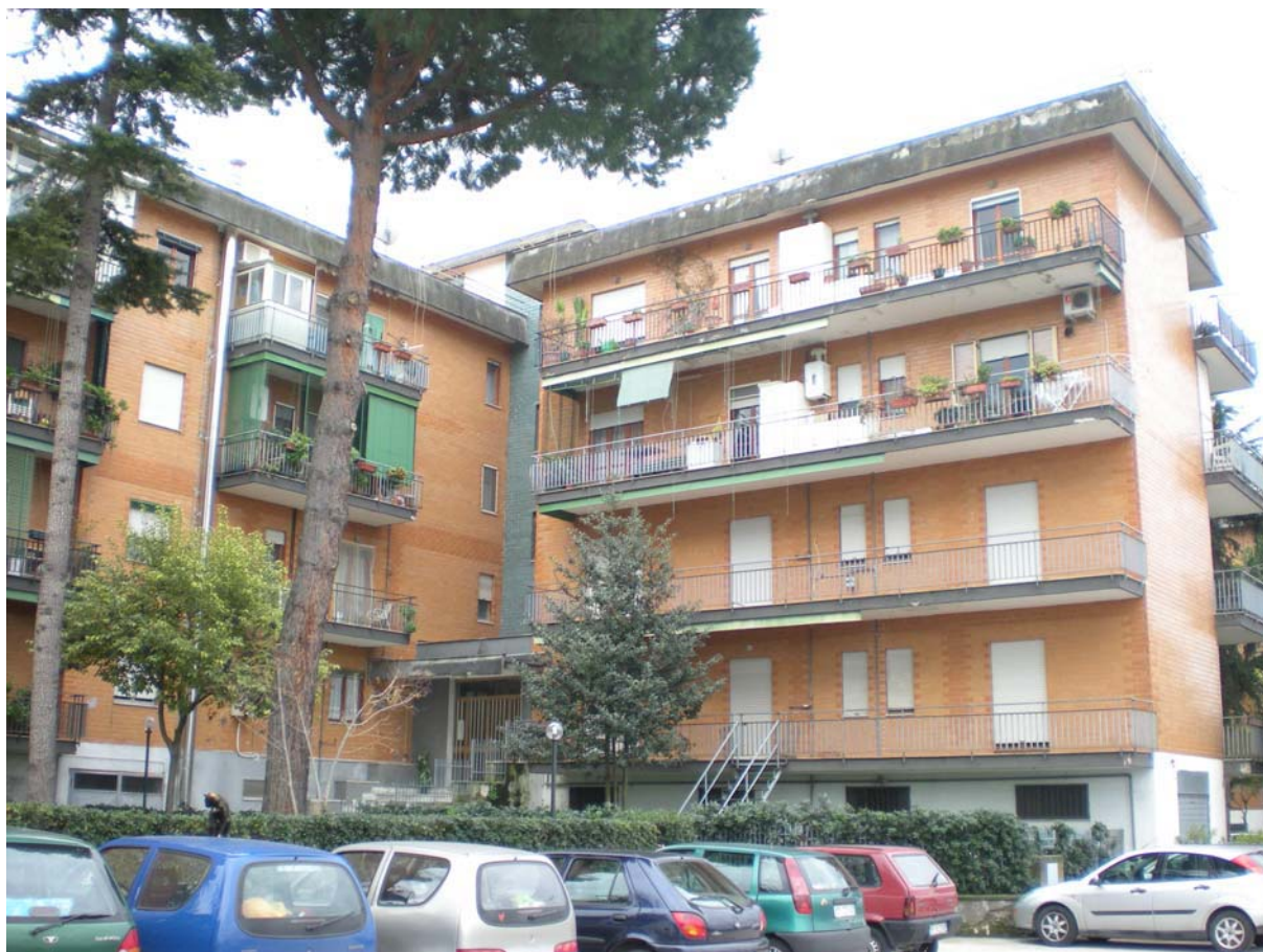
Foto n° 5 – Vista dell’immobile accesso scala B
