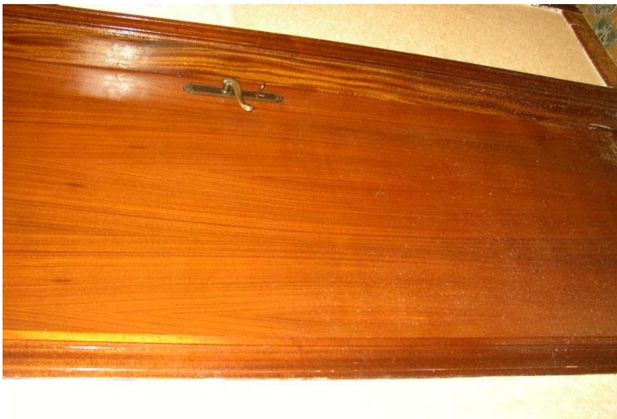
Foto n°8 – Particolare porte interne
