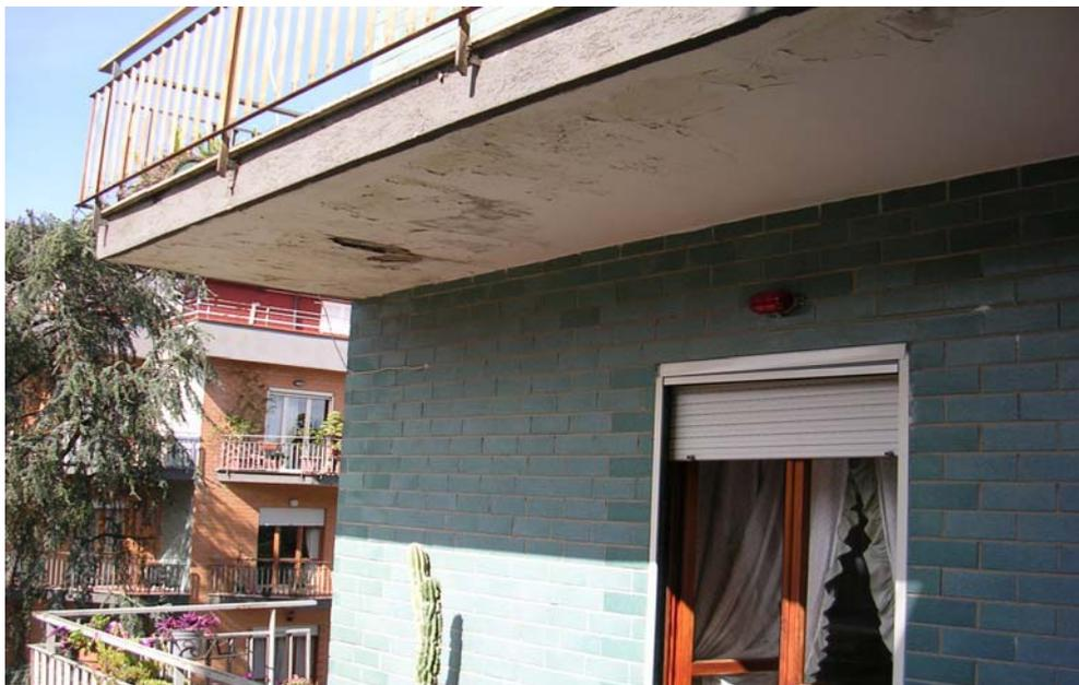
**Foto n° 6 – Particolare stato intradossi – frontalini balconi**
