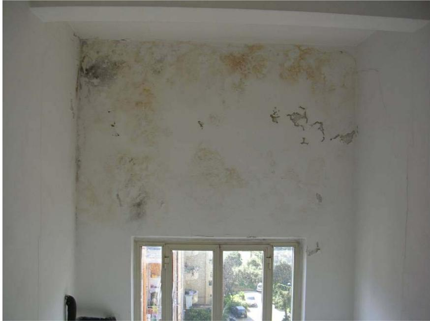
**Foto n° 11 – Particolare infiltrazioni provenienti dal terrazzo di copertura**
