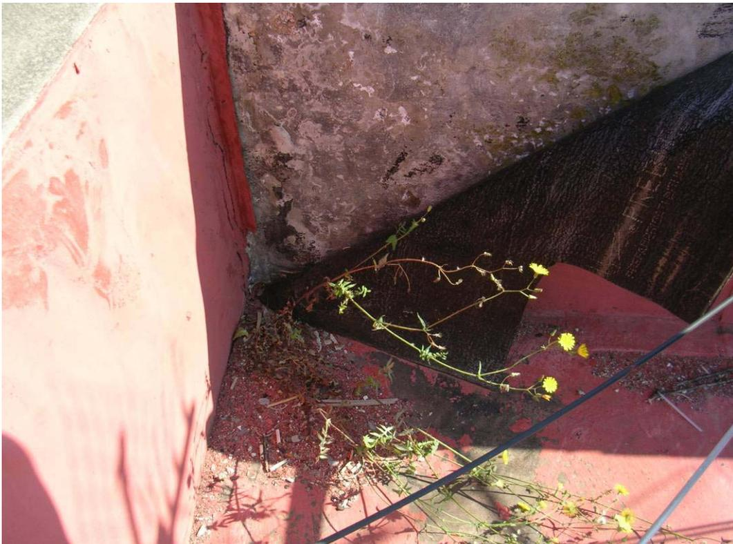
**Foto n° 10 – Particolare vetustà impermeabilizzazione terrazzo di copertura**
