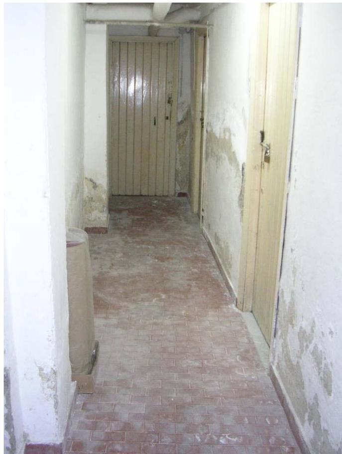
**Foto n° 12 – Particolare umidità e infiltrazioni cantinole**
