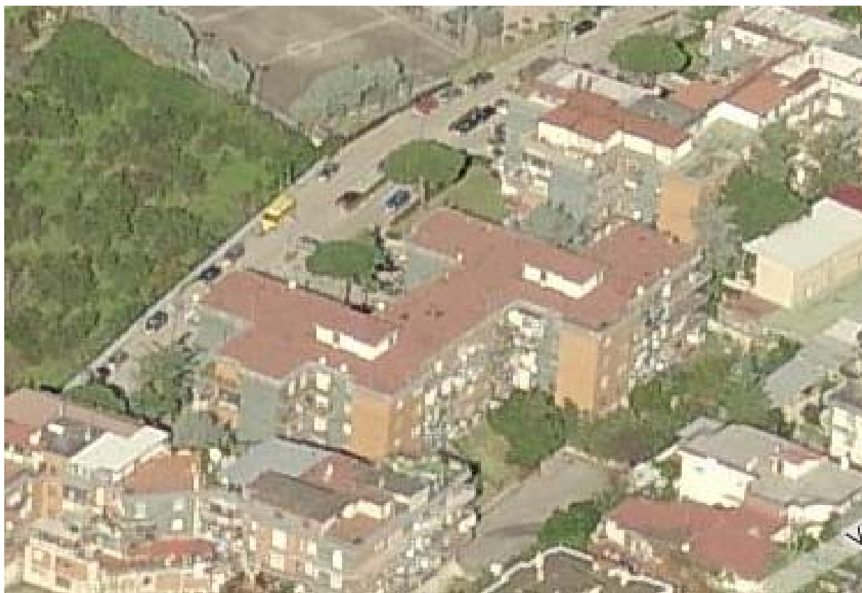
Foto n° 3 – Vista dell’immobile dal lato sud sud-ovest
