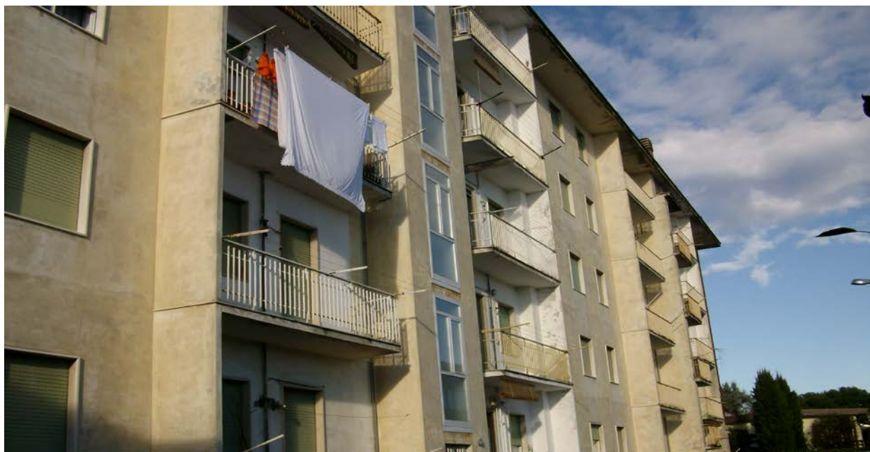
prospetto lato cortile
