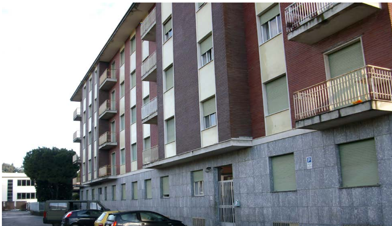
prospetto lato strada
