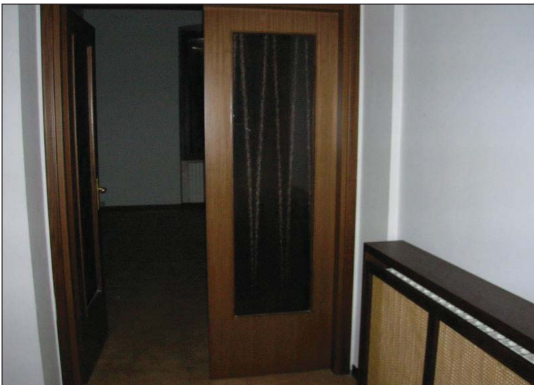
Foto 4 - porta interna in legno con vetrata.
