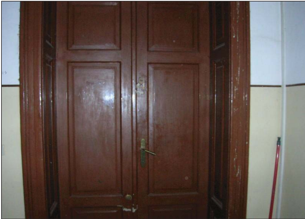
Foto 5 – porta esterna in legno rinforzato d'ingresso
