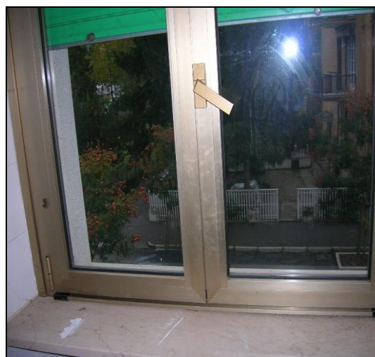
Foto 7 - Particolare fotografico dal quale si evince la tipologia e lo stato di conservativo degli infissi esterni (al piano terra in legno e al primo piano in alluminio).
