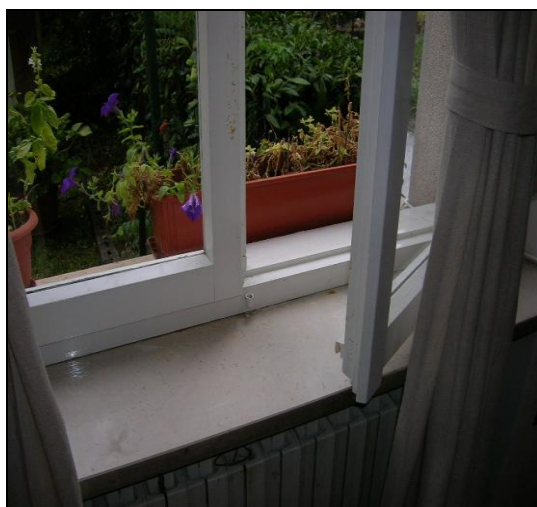
Foto 7 - Particolare fotografico dal quale si evince la tipologia e lo stato di conservativo degli infissi esterni (al piano terra in legno e al primo piano in alluminio).
