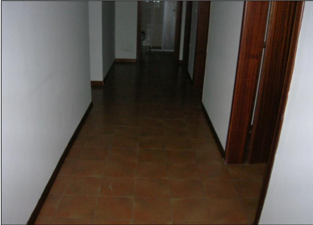
Foto 3 - stato manutentivo pavimentazione corridoio camere
