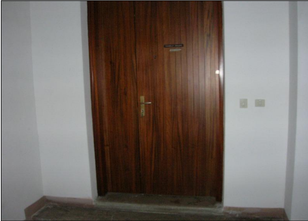
Foto 5 – porta esterna in legno tamburata d'ingresso
