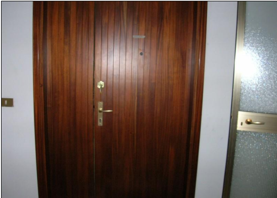
Foto 5 – porta esterna in legno tamburata d'ingresso
