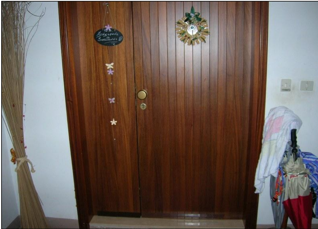
Foto 5 – porta esterna in legno tamburata d'ingresso
