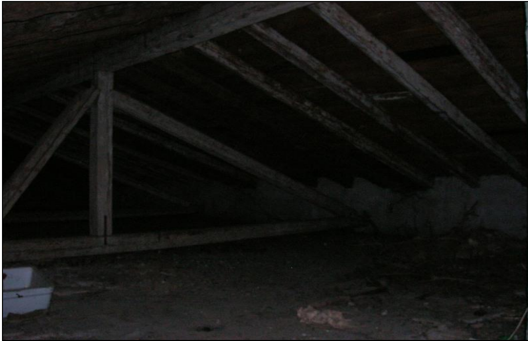
Foto 5 – Particolare fotografico dal quale si evince la tipologia di copertura dell'edificio (copertura a falde).
