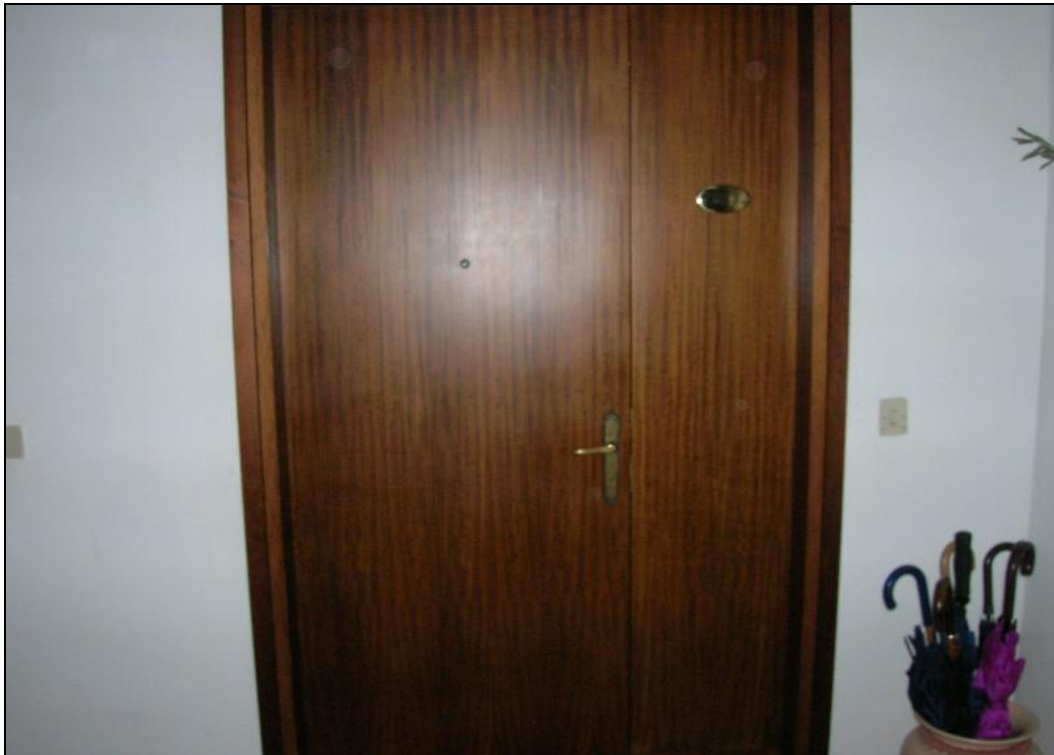
Foto 5 – porta esterna in legno tamburata d'ingresso
