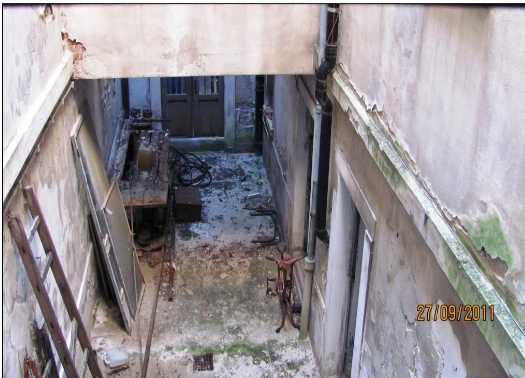
Foto 11 – particolare fotografico dal quale si evince lo stato attuale del cortile interno ed i relativi accessi alle cantine pertinenziali.
