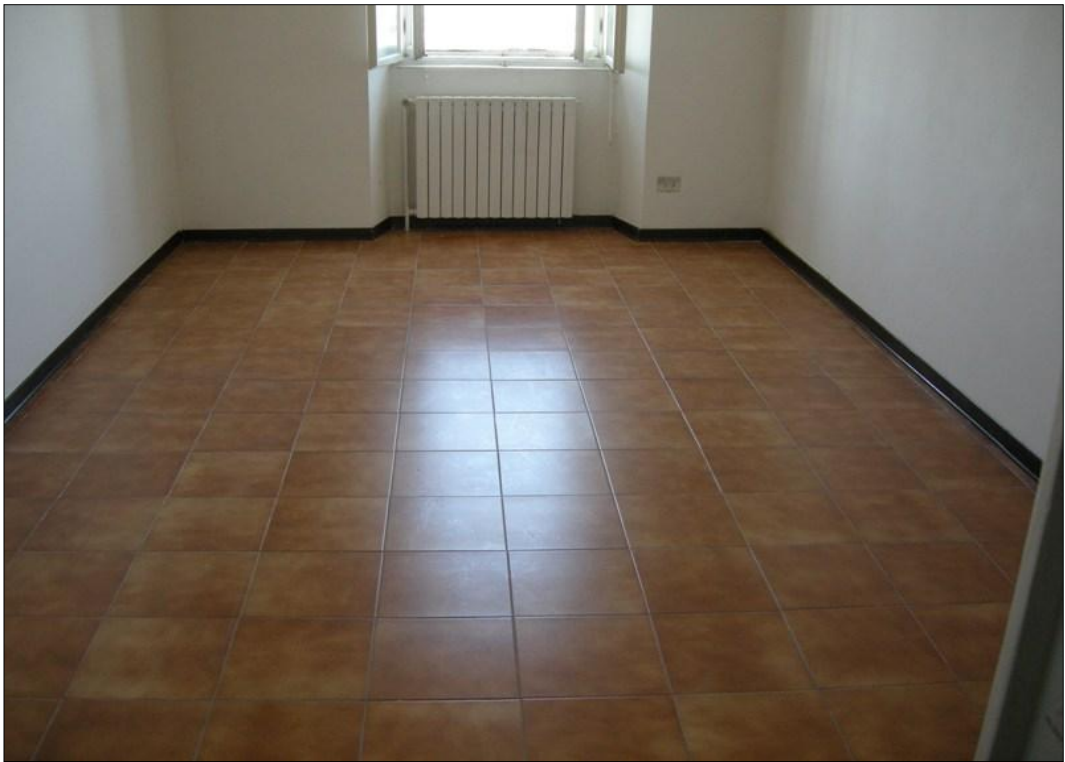
Foto 3 - stato manutentivo pavimentazione delle camere.
