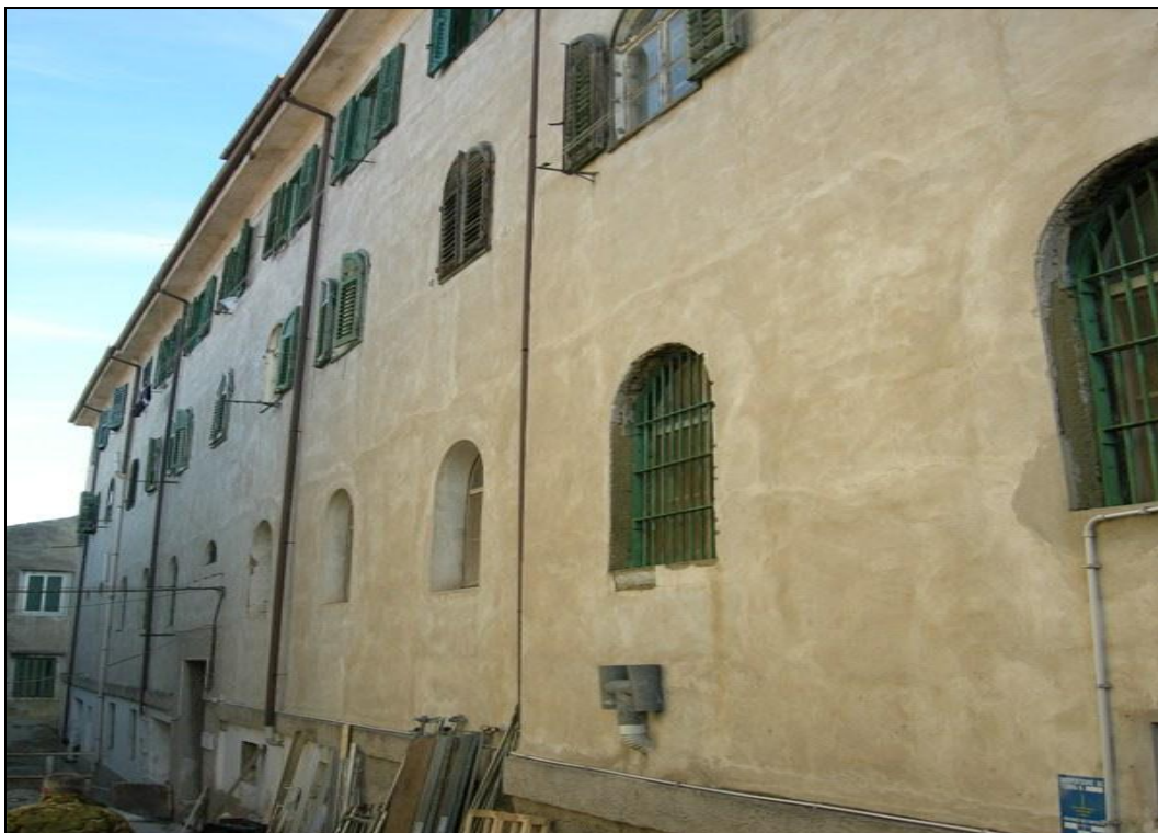
Foto 4 – Particolare fotografico dal quale si evince il numero di piani presenti nell'edificio.
