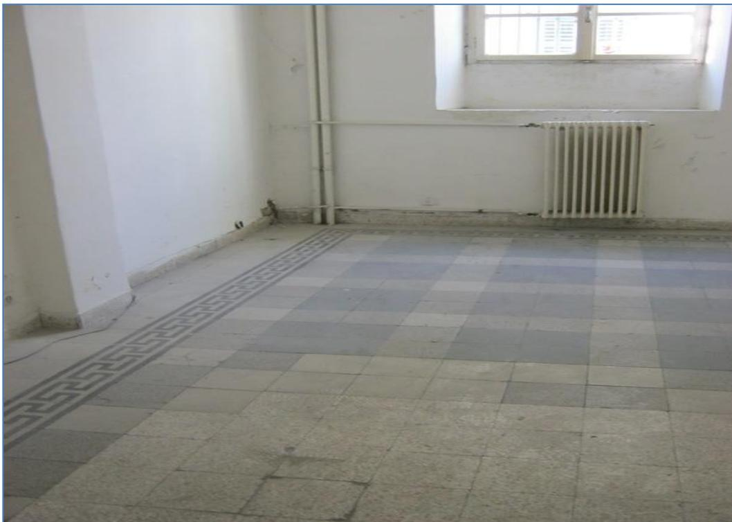
*Foto 1 - stato manutentivo pavimentazione stanze*
