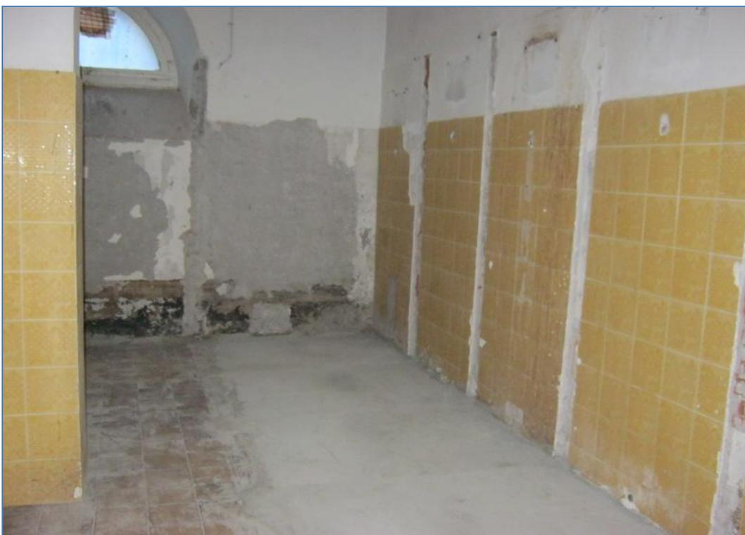
*Foto 2 - stato manutentivo pavimentazione del bagno.*
