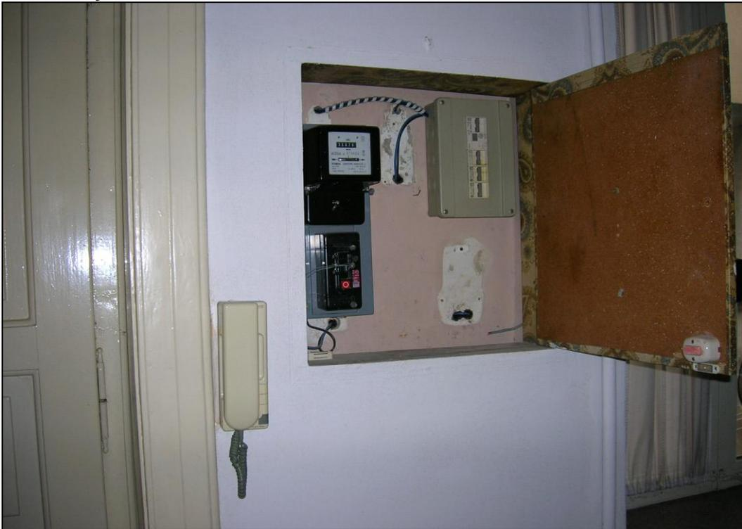
*Foto 6 – quadro elettrico dell'unità immobiliare (impianto elettrico non a norma).*
