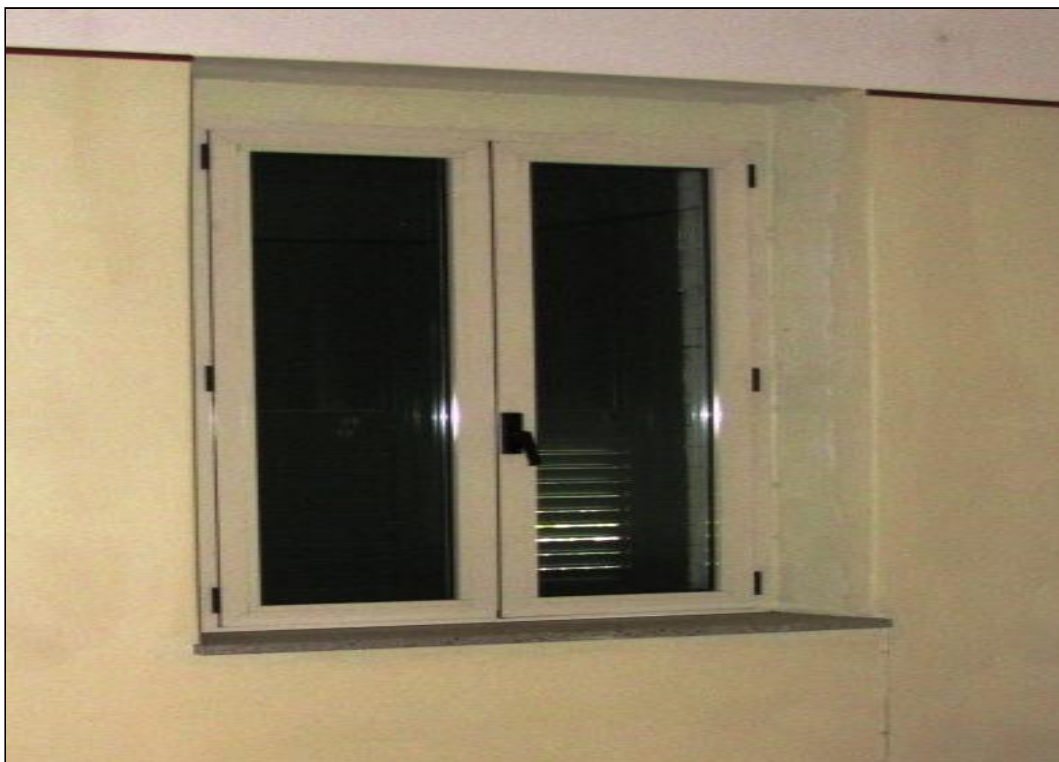
Foto 8 - Particolare fotografico dal quale si evince la tipologia di infissi esterni con vetrocamera.
