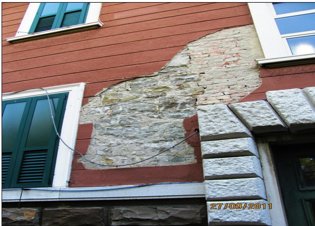
Foto 6 - Particolare fotografico dal quale si evince la tipologia di struttura mista pietra/mattone e il degrado dell'intonaco esterno.
