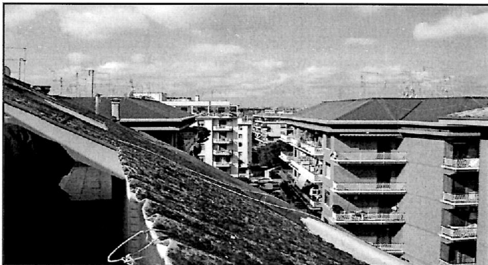
Foto 22 – Particolare della copertura – lastre in eternit.
