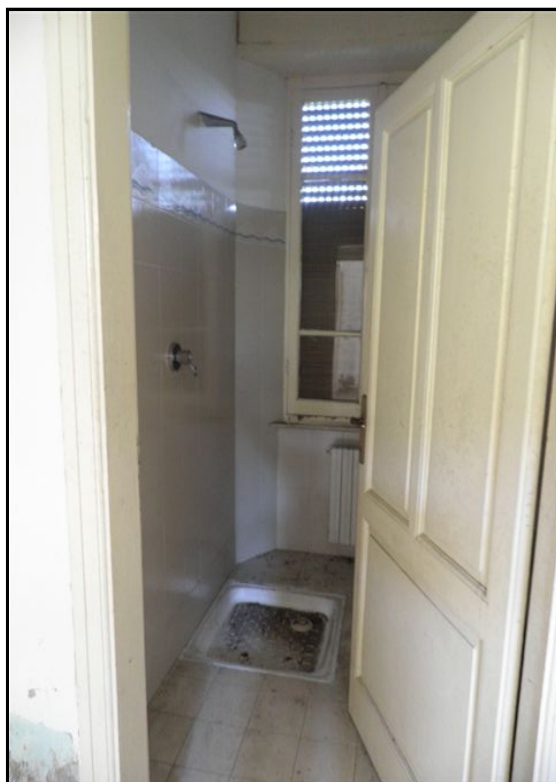
Foto 13 – Piano Terra. Bagno
