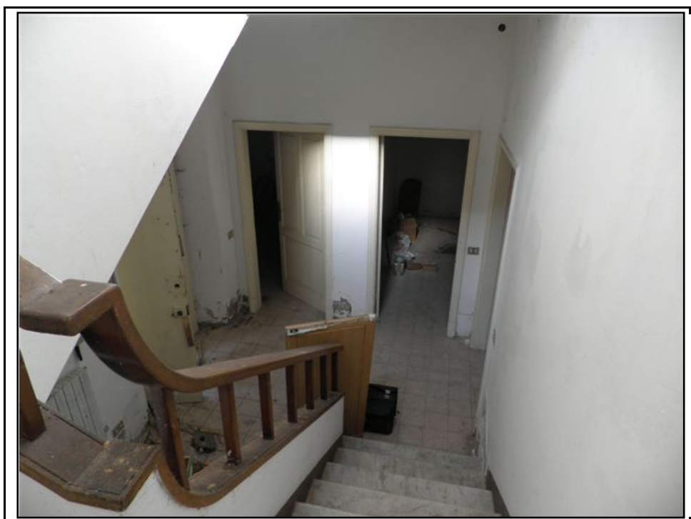
Foto 4 – Piano Terra. Ingresso e vano scala interno
