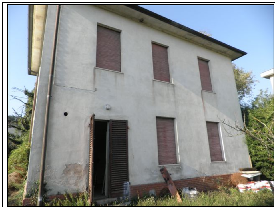
Foto 2 – Prospetto ed ingresso secondari (lato cucina)
