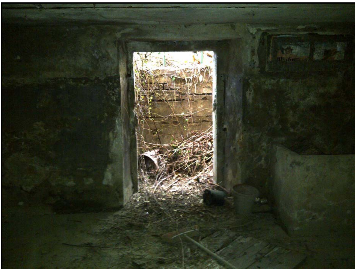
Foto 15 – Piano Interrato. Ingresso cantina (lato interno)
