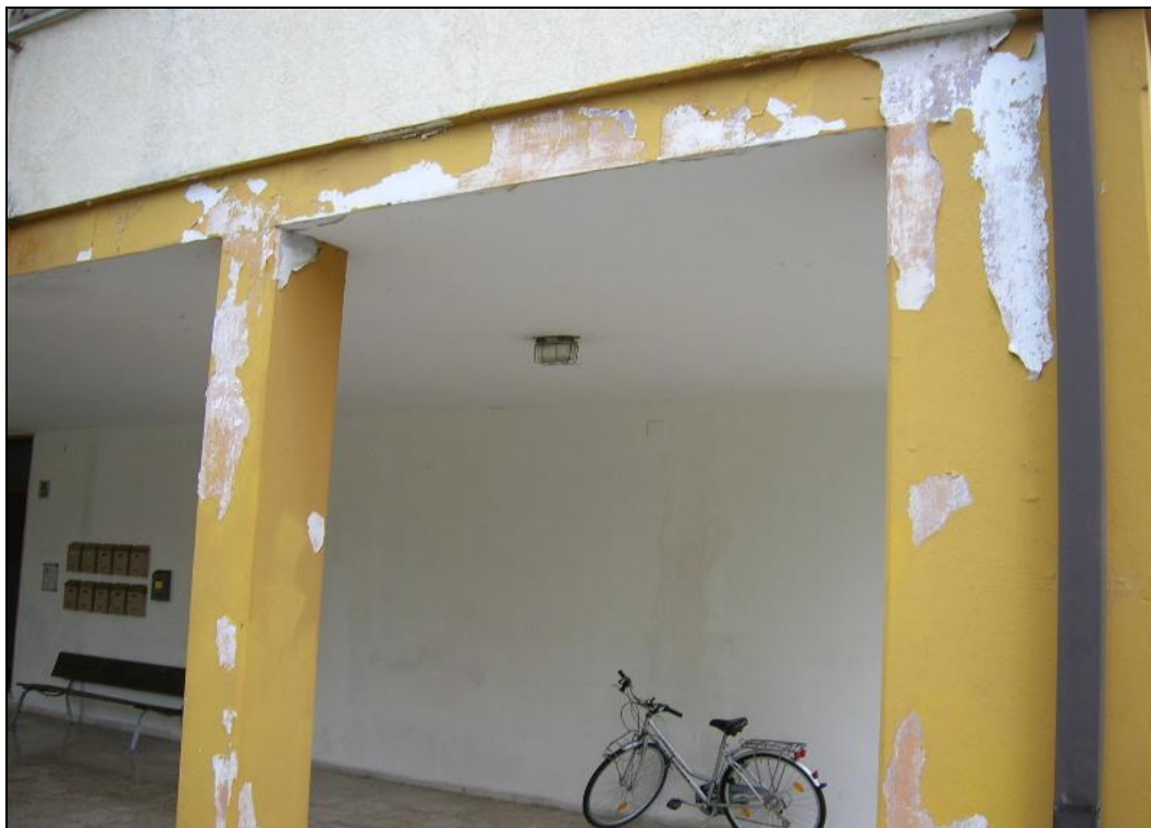
Foto 9 - Particolare fotografico del distacco della tinteggiatura nella facciata esterna
