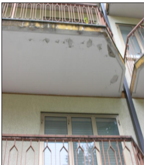
Foto 8 - Particolare fotografico delle condizioni dell'intonaco della facciata esterna
