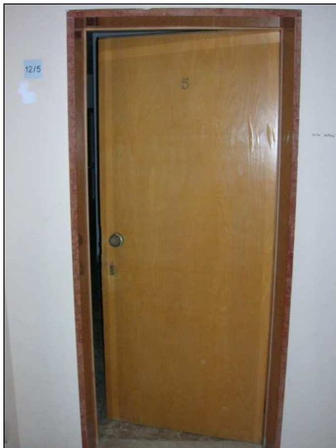
Foto 6: porta in legno d'ingresso rinforzata.
