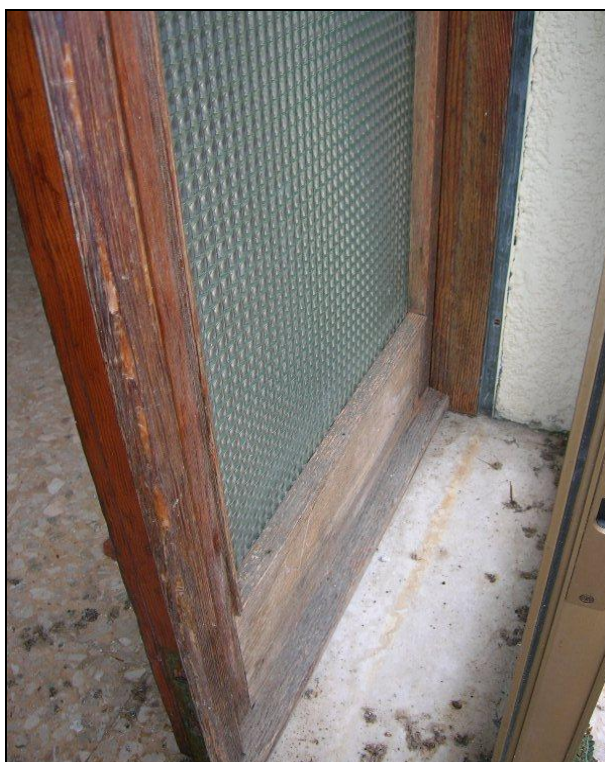
Foto 12 - Particolare fotografico del pessimo stato dell'infisso esterno in legno.
