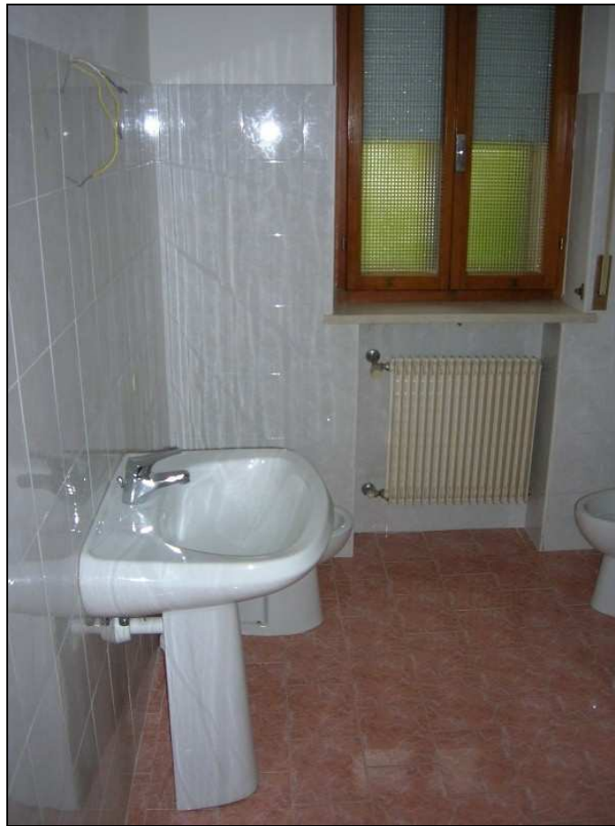
Foto 3: stato manutentivo pavimentazione e rivestimento del bagno.
