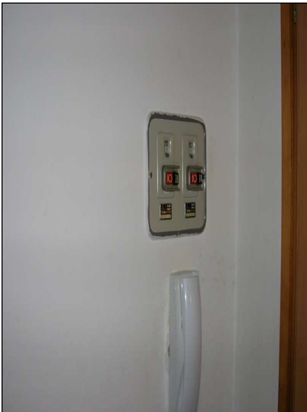
Foto 8: quadro elettrico d'appartamento e generale
