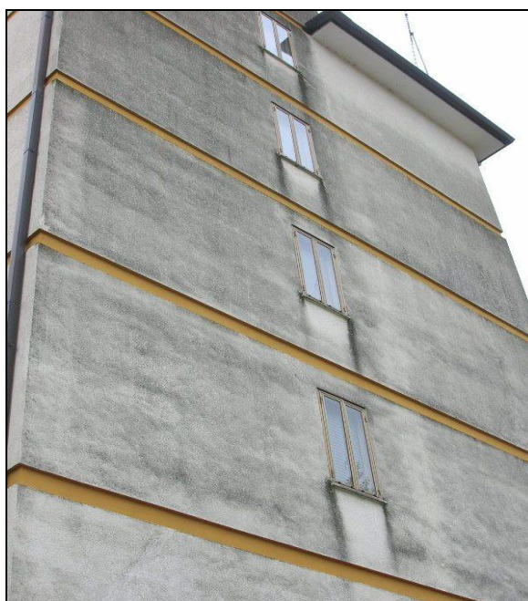
Foto 8 - Particolare fotografico delle condizioni dell'intonaco della facciata esterna
