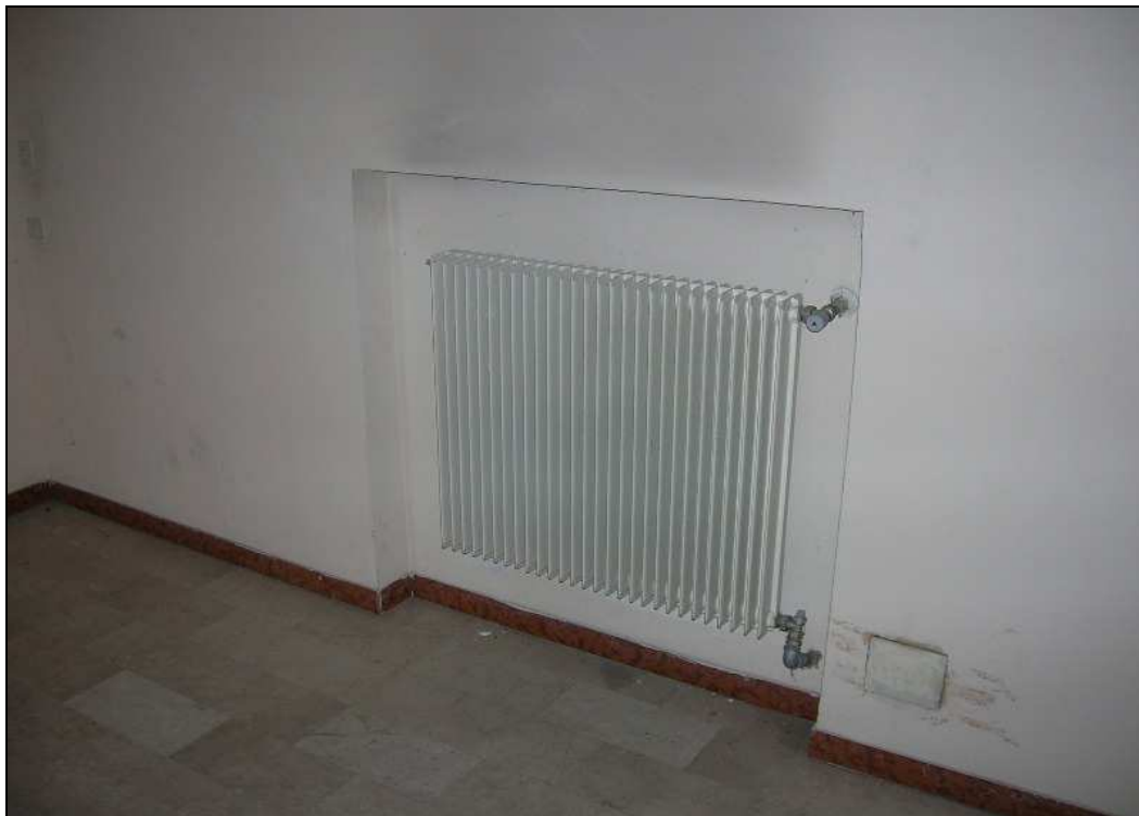
Foto 4: stato manutentivo pavimentazione ingresso/corridoio.
