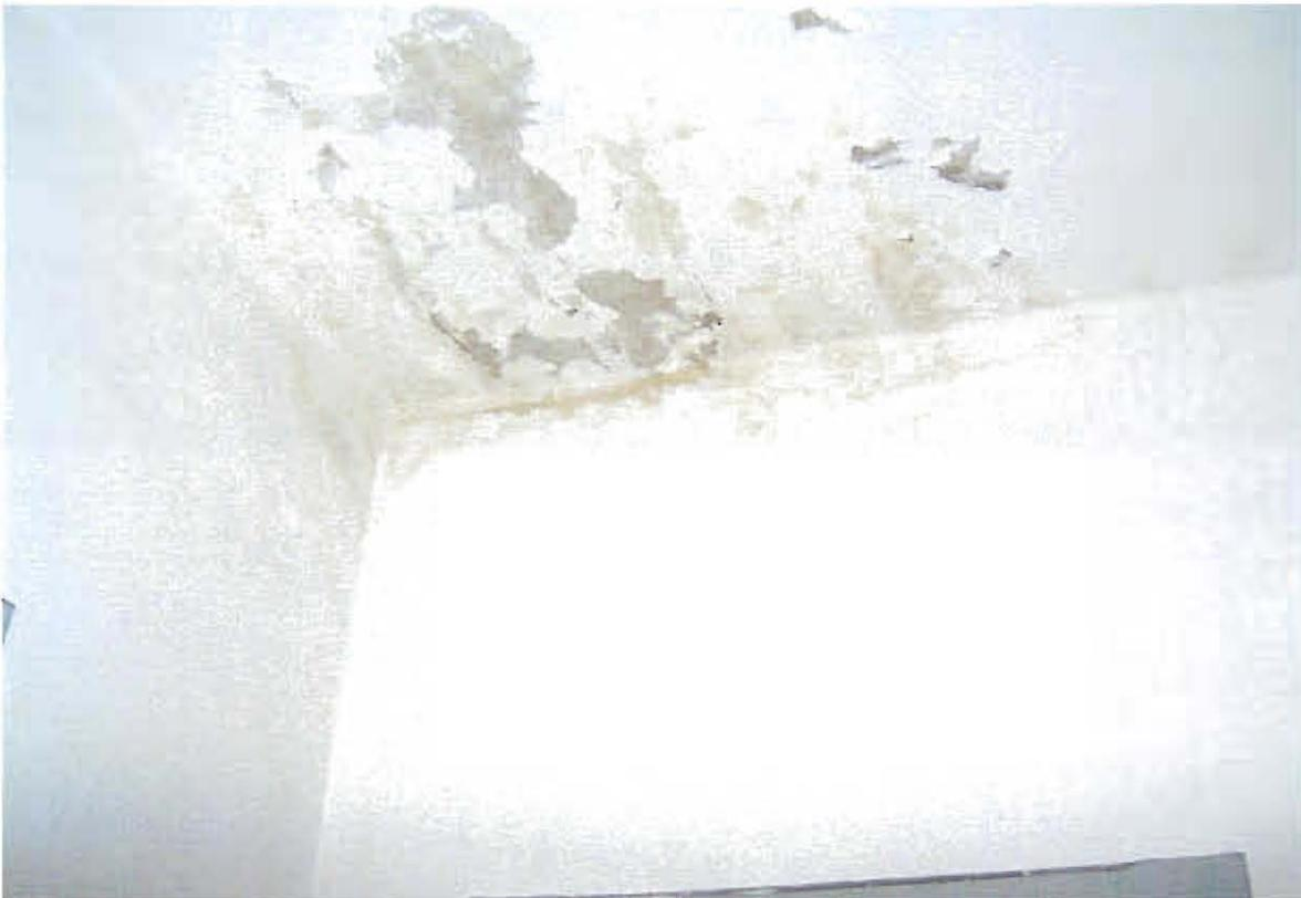
**Foto n.8 (particolare pareti interne, punto soggetto a infiltrazioni da lastrico solare)**
