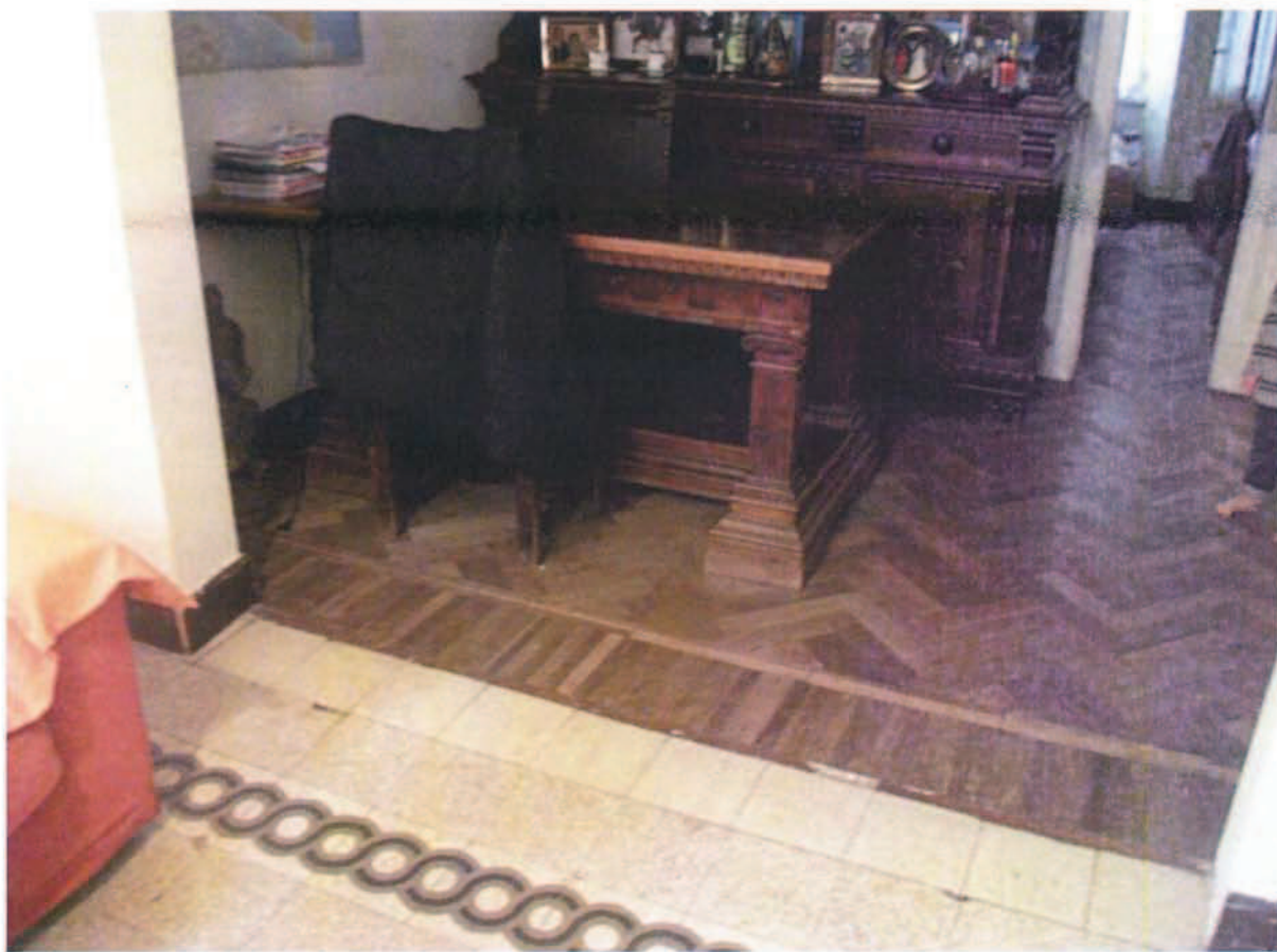
Particolare pavimentazioni INGRESSO-SOGGIORNO
