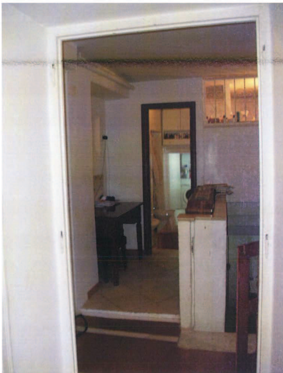
Sbarco scala interna e area antibagno
