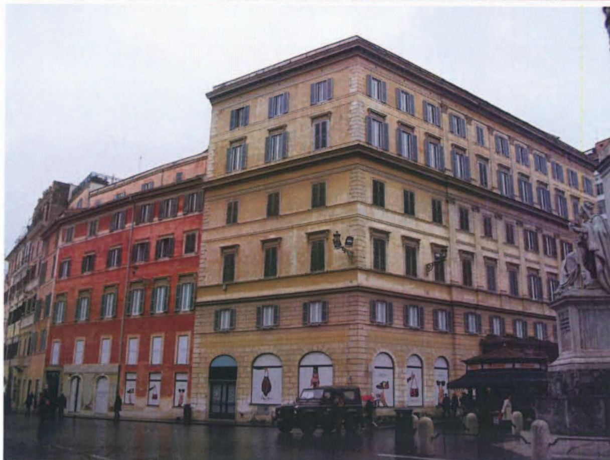
Vista del complesso immobiliare prospetto Piazza di Spagna-Piazza Mignanelli
