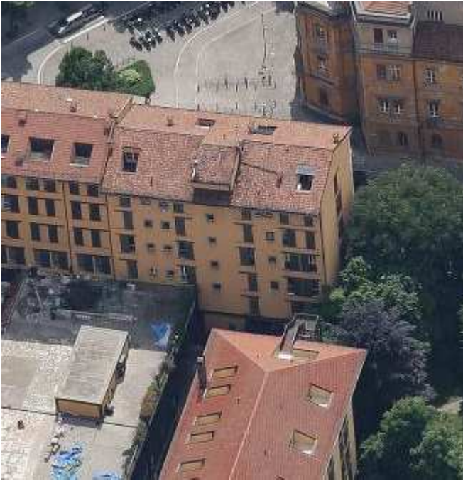
FOTO AEREA DELLA FACCIATA NORD
