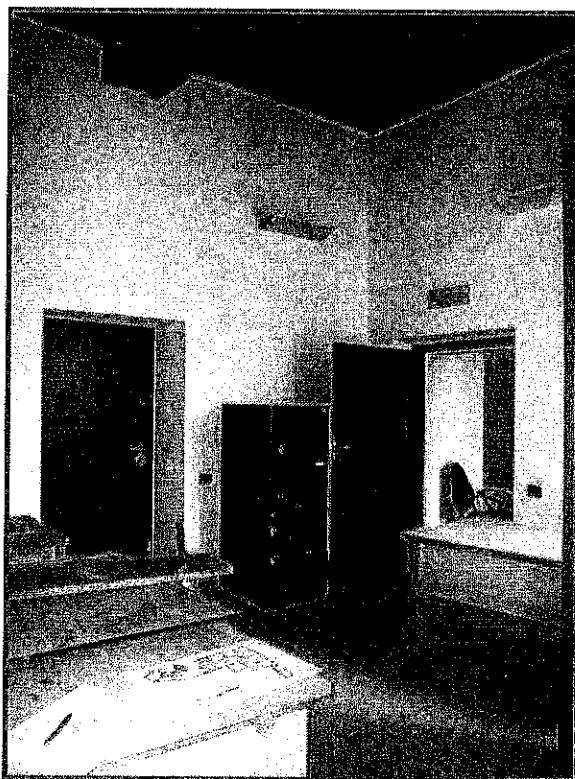
Foto 8 – PORTA DI ACCESSO DAL CIV.17 – CAMERA 4
