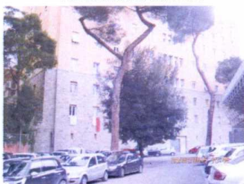
Vista lato Stadio Comunale
