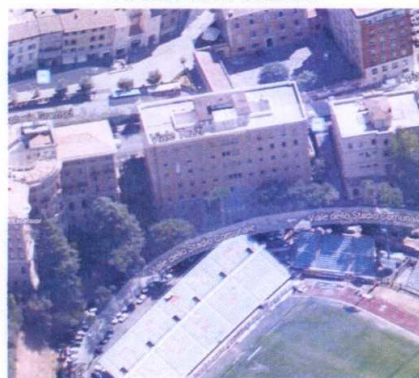
Vista lato Stadio Comunale
