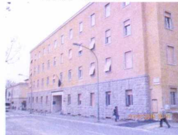
Vista lato Viale F. Tozzi
