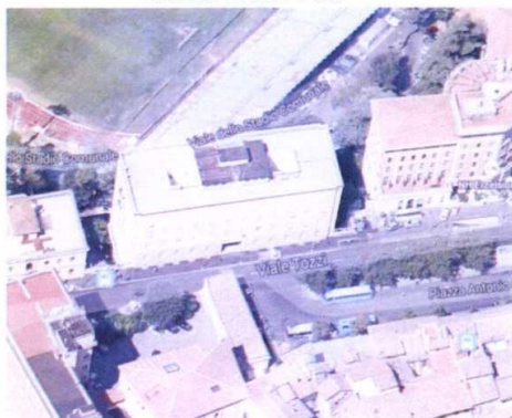
Vista lato Viale F. Tozzi
