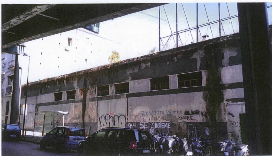
FOTO N°16 - Il Corpo C - Il prospetto su Corso Malta
