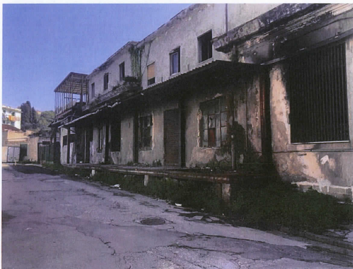
FOTO N°4 - Il Corpo B - Il prospetto laterale su Traversa Malta
