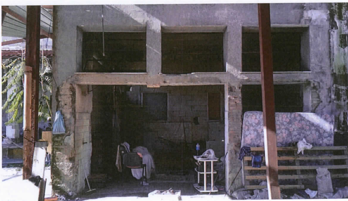
FOTO N°14 - Particolare del Corpo B dall'area scoperta comune
