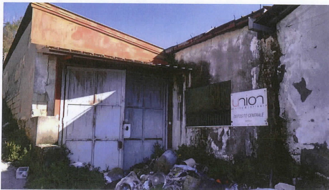
FOTO N°6 - Il Corpo A - Entrata carrabile da Traversa Malta
