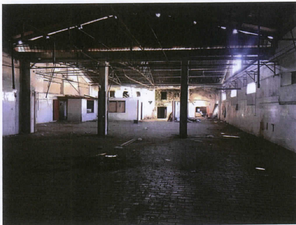
FOTO N°7 - Il Corpo A - Vista interna del capannone principale
