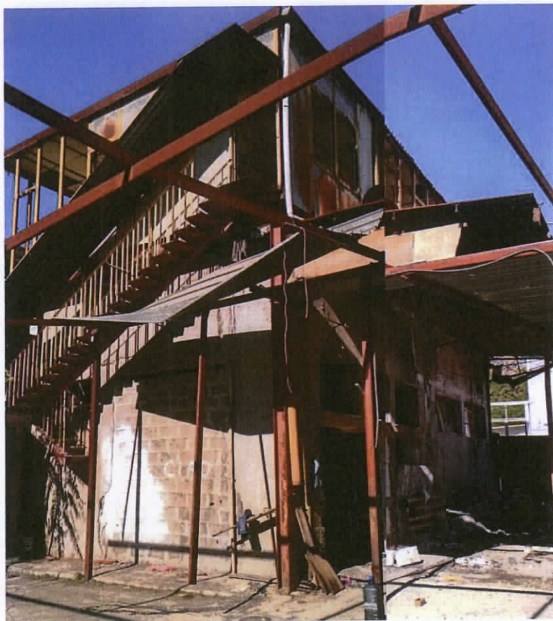
FOTO N°13 - Il Corpo B - Le superfetazioni all'estremo Nord-Est del fabbricato
